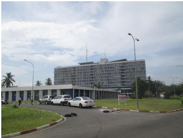
Vue générale du CHU (ouvert en 1970) Le bloc de service des urgences élargi en 2015 se trouve devant le bâtiment principal
