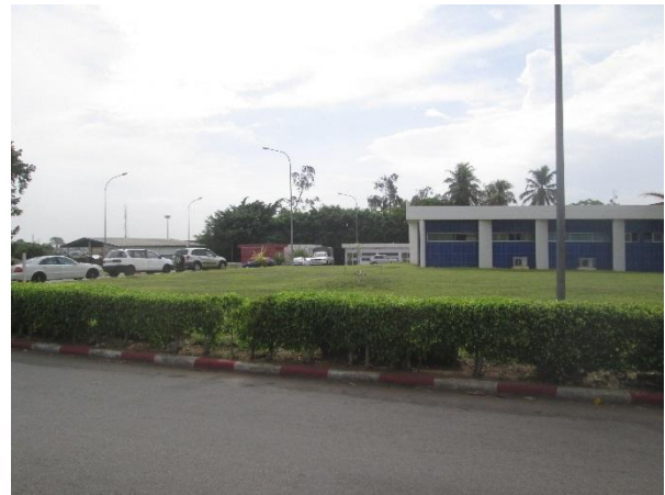
Etat actuel du site du Projet Les postes électriques et la salle mécanique des gaz médicaux situées au fond, devront être déplacées ou délogées avant la construction.
