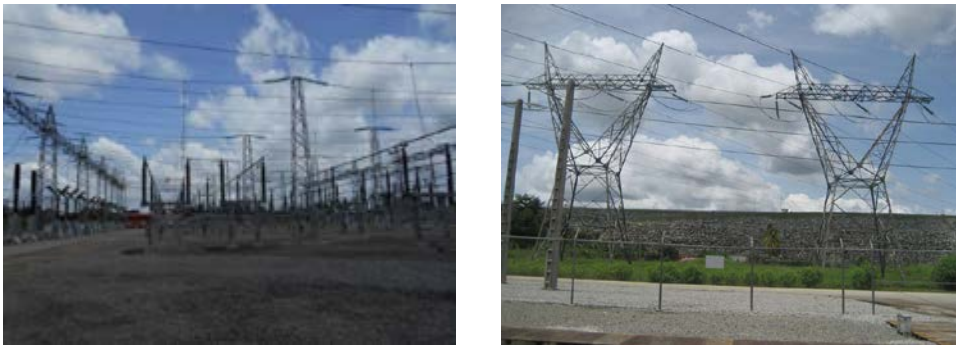
Figure 7.12 Jeux de barres dont l'extension a été réalisée (à gauche) et espace d'installation des équipements de sectionnement (à droite)
