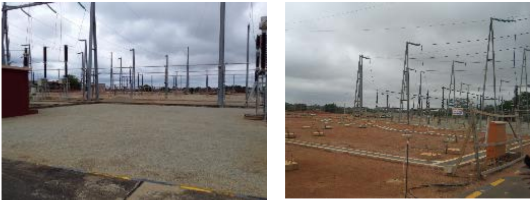
Figure 7.22 Situation des travaux de raccordement de la ligne de transport direction
