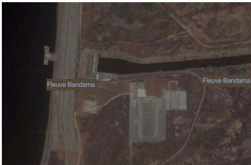
Figure 7.11 Centrale et poste de Taabo
