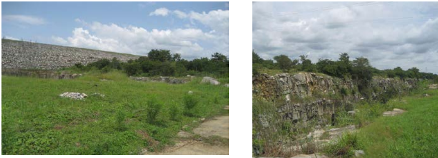
Figure 7.13 Emplacements prévus pour la construction du pylône No. 1 de la ligne de transport (à gauche) et emplacement du pylône No. 2 sur la rive opposée d'un canal d'évacuation
