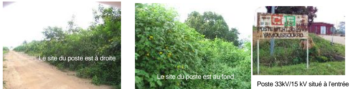
Figure 7.8 Emplacement candidat pour la construction du nouveau poste de Yamoussoukro2
