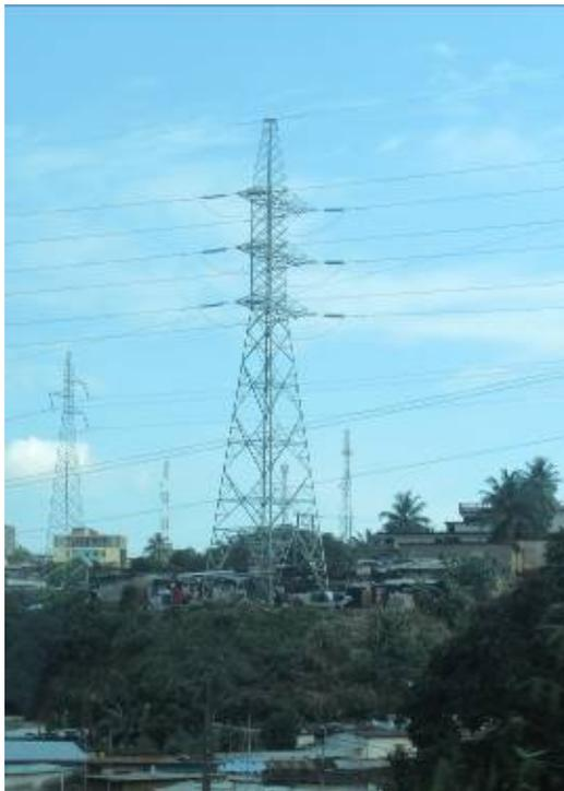
Figure 4.6 Pylône en treillis 225 kV
