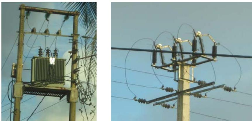
Figure 4.24 Transformateur sur poteau et sectionneur de sectionnement à commande manuelle
