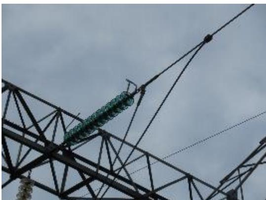
Figure 4.14 Chaîne isolante équipée
