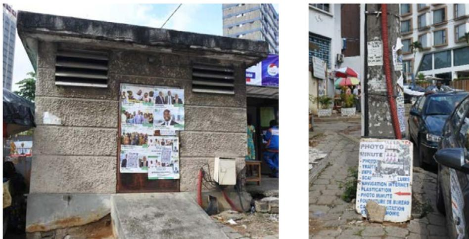
Figure 4.22 Poste de distribution et situation d'une ligne montante sur poteau
