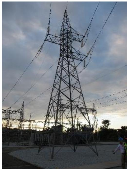
Figure 4.9 Pylône en treillis 90 kV
