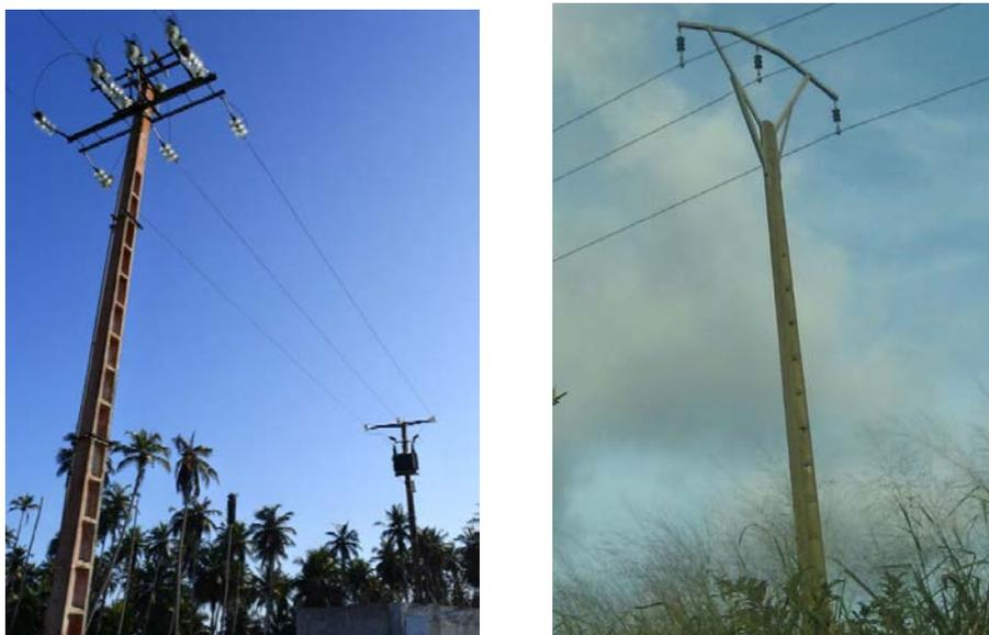
Figure 4.23 Poteaux de distribution en béton standardisés
