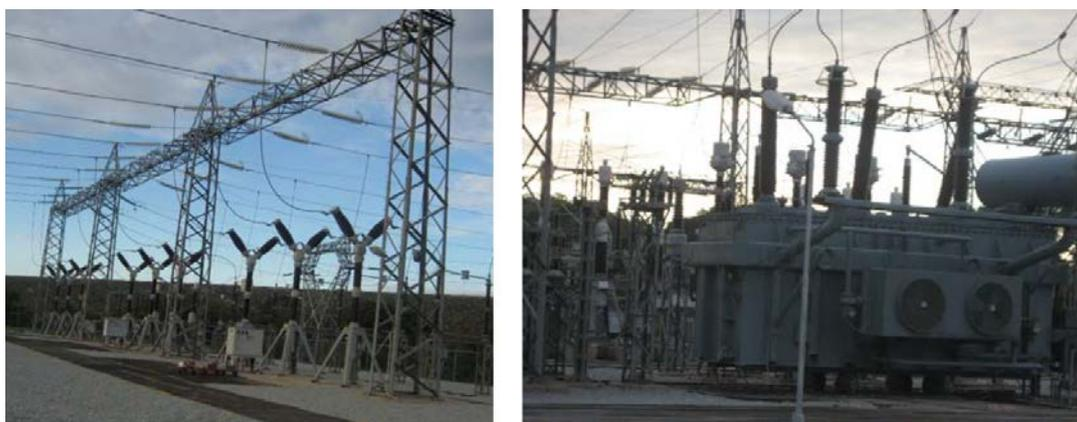
Figure 4.21 Équipements de transformation 225 kV
