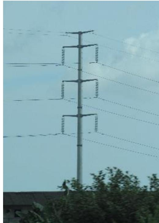
Figure 4.7 Pylône monopode 225 kV
