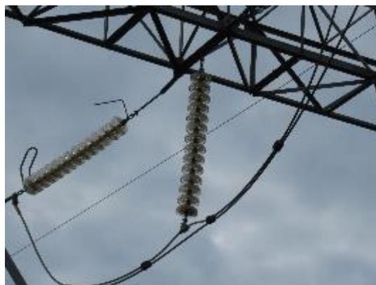
Figure 4.15 Chaîne isolante équipée
