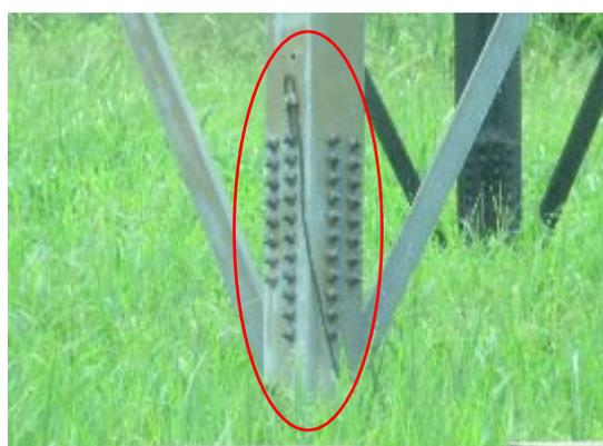
Figure 4.11 Mise à la terre de pied de pylône
