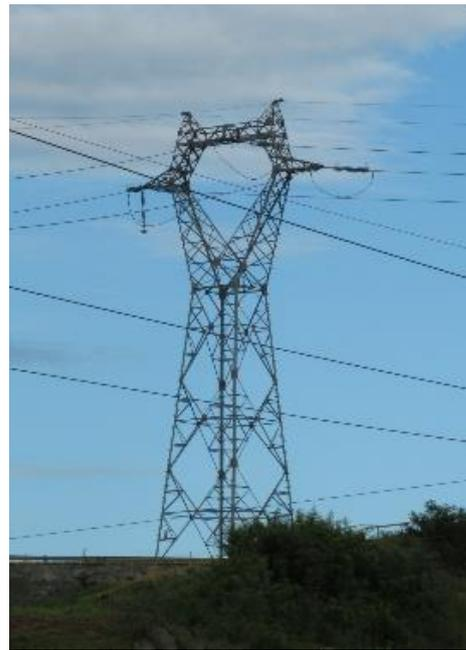
Figure 4.5 Pylône en treillis 225 kV
