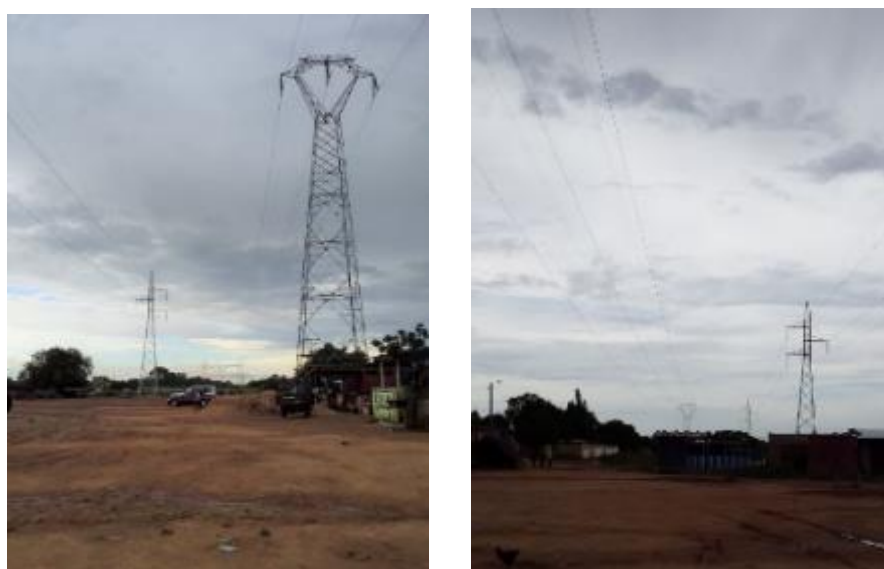
図 7.4 集落周辺の送電線通過状況
