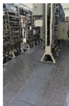
図 7.14 制御・保護装置 収納建屋の状況
