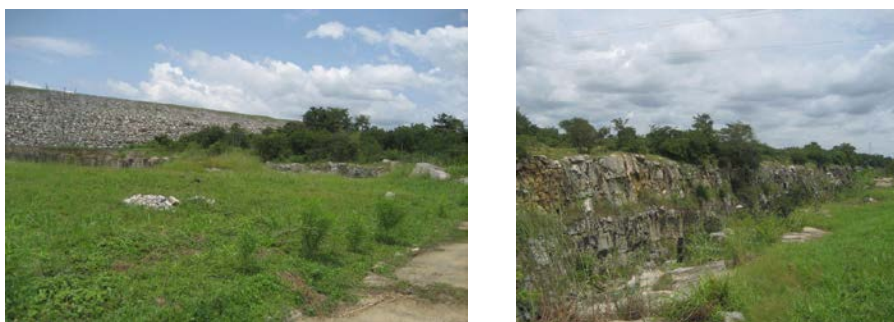
図 7.13 送電線第 1 鉄塔建設地点（左）と排水路を隔てた対岸第 2 鉄塔位置
