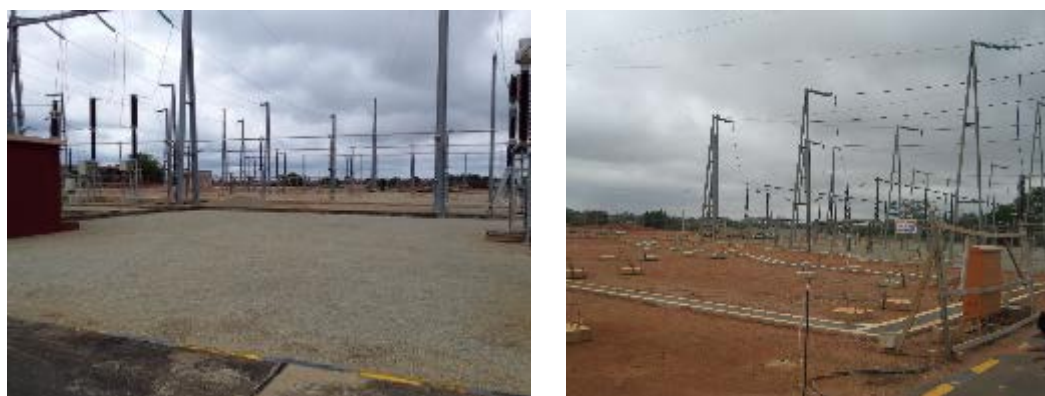
図 7.22 Soubre 方面送電線引出し工事の状況
