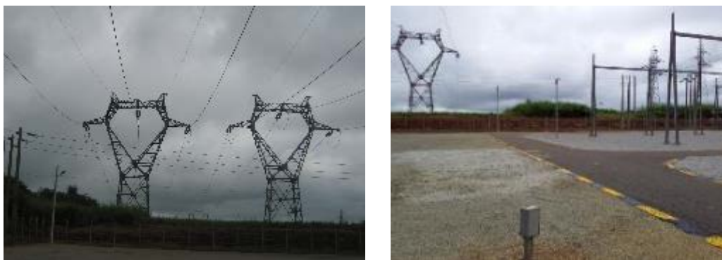
図 7.21 既設送電線の引込状況
