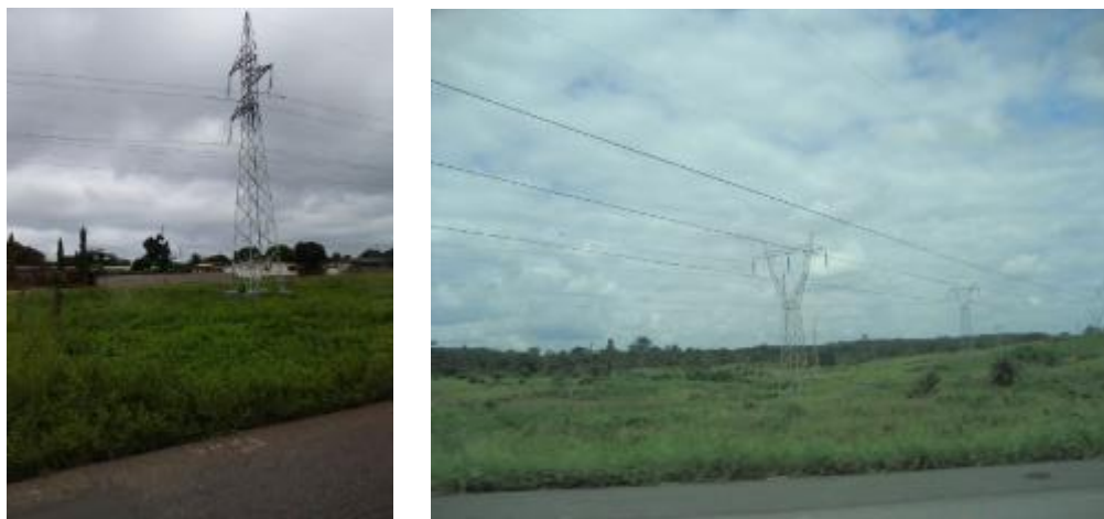
図 7.3 既設送電線の線下状況
