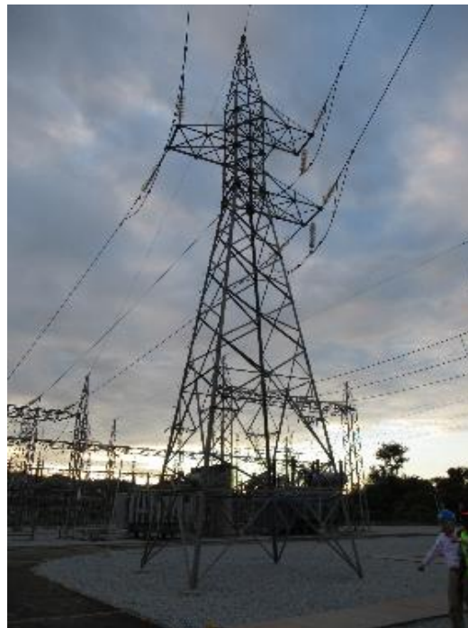
図 4.9 90kV 山形鉄塔 (四角鉄塔、1回線、耐張、Kossou S/S)
