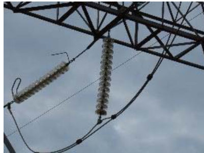
225kV山形鉄塔 (四角鉄塔、2回線、耐張)
