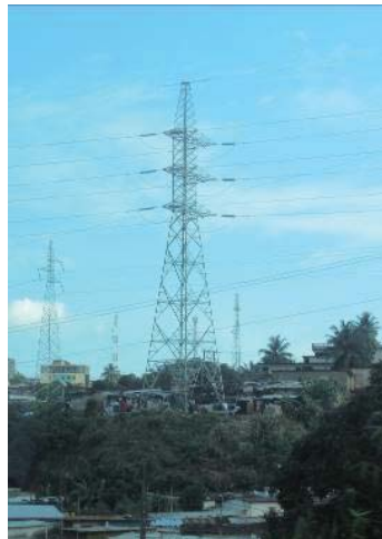
225kV山形鉄塔 (四角鉄塔、2回線、耐張)
