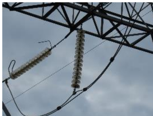
図 4.15 がいし装置 (ジャンパー支持、ガラス製がいし)
