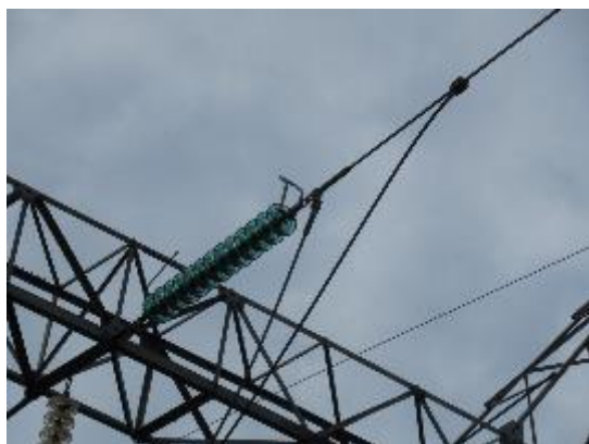
図 4.14 がいし装置 (1連耐張、懸垂、ガラス製がいし)
