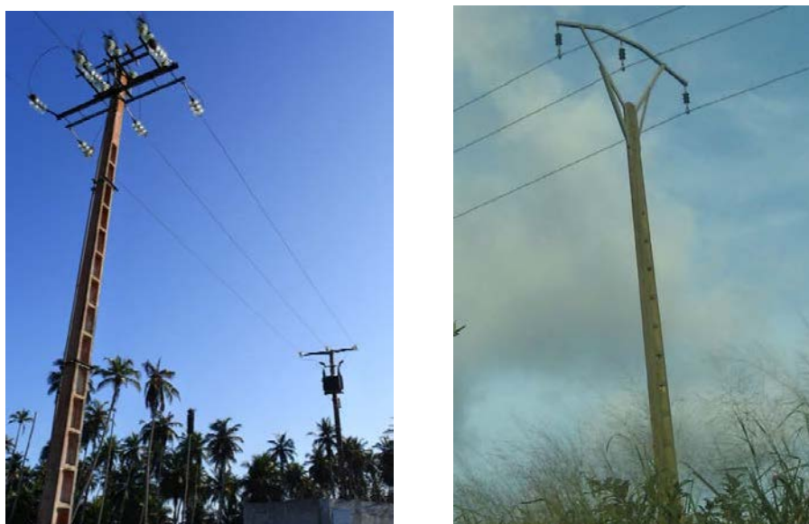
図 4.23 標準化されたコンクリート製配電柱
