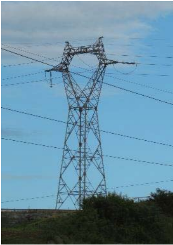
225kV山形鉄塔 (烏帽子型、1回線、耐張)
