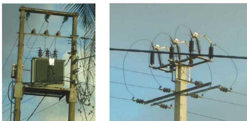
図 4.23 標準化されたコンクリート製配電柱
