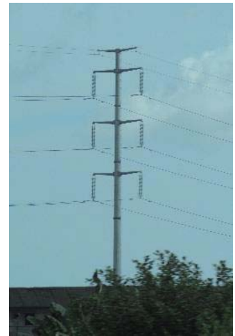
225kV単柱 (角型断面、2回線、懸垂)
