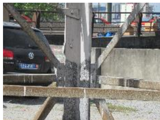
図 4.19 防錆塗装状況 (Abidjan 周辺)
