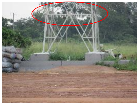
図 4.10 付帯設備 (昇塔防止装置)
