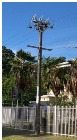
写真 2-11 コンクリート柱
