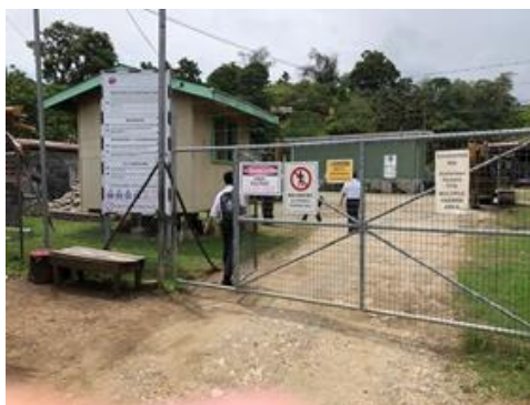
写真 2-5 ホニアラ発電所
