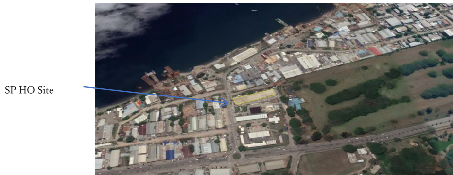
図 3-4 ソロモンパワー本社社屋サイト
