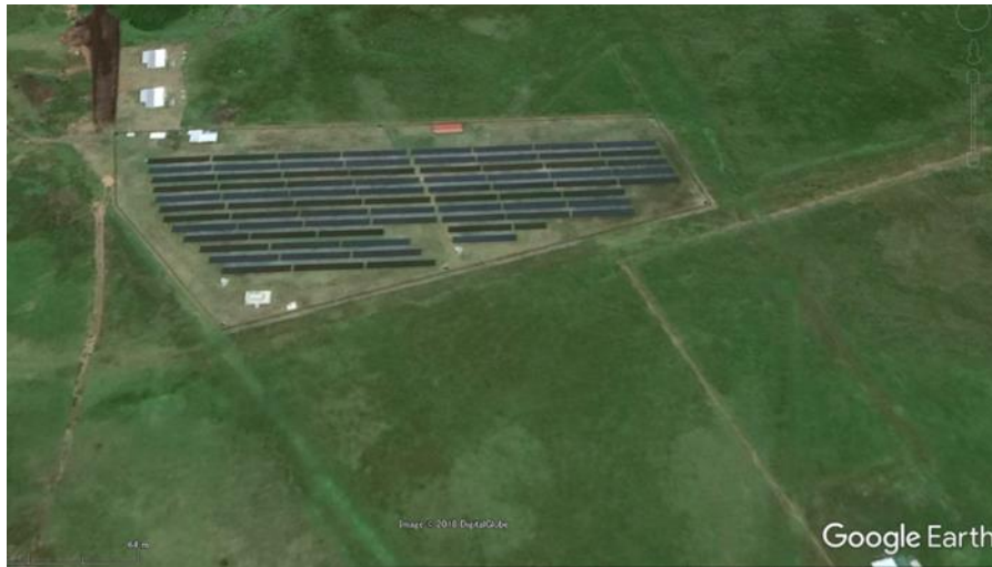
写真 2-6 ファイターワン発電所
