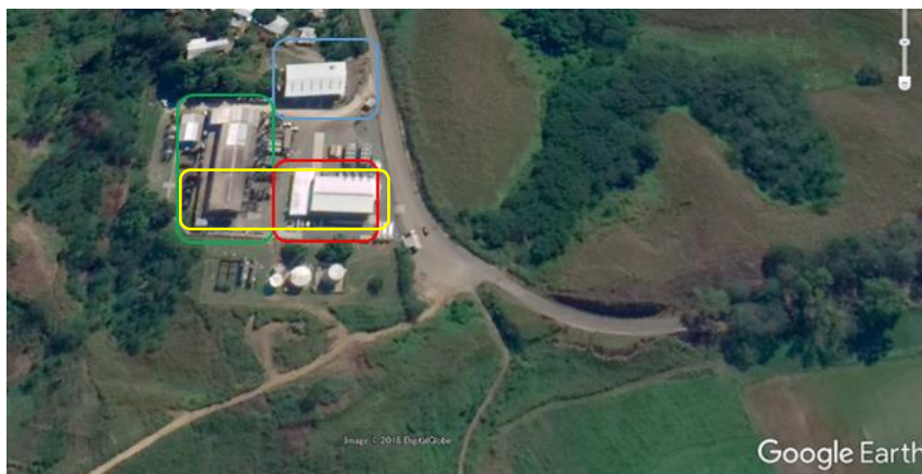
図 2-9 ルンガ発電所
