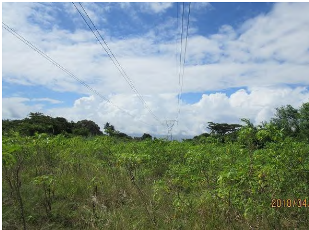
写真 3: 敷地の東側、国道沿いに高圧線が通っている。
