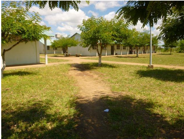
写真 1: Samora Machel 中学校。世銀プロジェクトで建設され 2010 年に開校。対象 5 郡では唯一中学校に必要な施設が完備されている。
