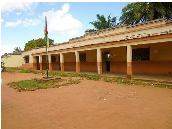
写真 5: EPC Erurune。調査対象である Alto Lugela 校の分校が借用教室で運営されている。もとはミショナリー系施設であったとのこと。
