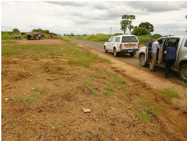
写真 1: 計画地の現況。舗装された幹線道路 (EN229) に面する。舗装部分幅員約 8m で片側 1 車線。
