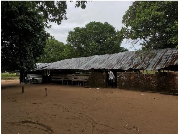
写真 1: 4 de Outubro 小学校。コミュニティにより建設された仮設木造校舎。
