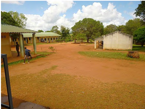
写真 1: ESG de Lugela 全景。緩やかな斜面に沿って平屋の建物を分散配置している。施設は小学校を転用したもので、特別教室等はない。郡内で唯一 ESG2 を備える。
