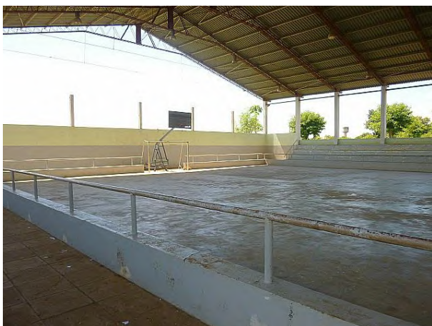
写真 5: 屋根付き運動場。壇上の観覧席が両側に設けられ、更衣室は別棟となっている。オープンな形式のため、降雨時には雨が吹き込む。
