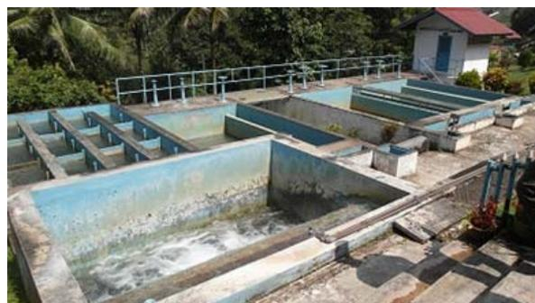
写真-10：プーポン浄水場（着水井、フロック形成池、ろ過池）
