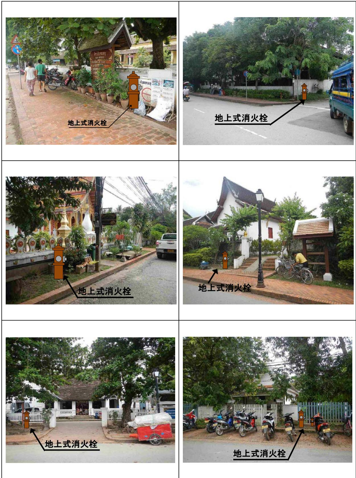
写真 3.2.5 消火栓設置のイメージ (地上式消火栓)
