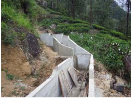
写真 15 地表排水工事
