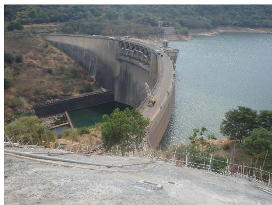
写真 59 施工済みのコンクリート吹付
