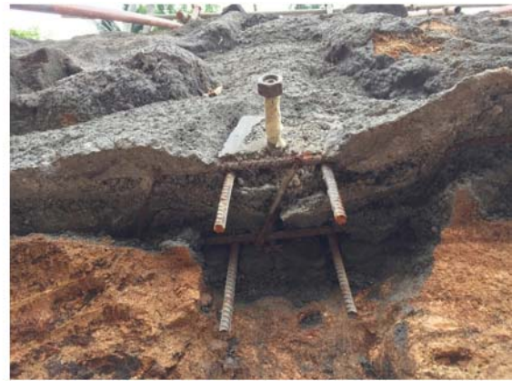
写真 18 頭部連結工接写
