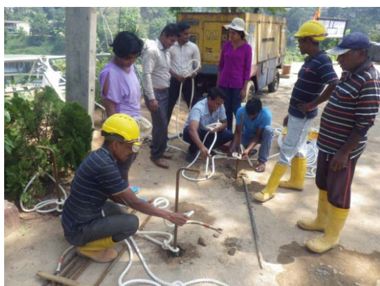
写真 23 法面作業の技術指導①
