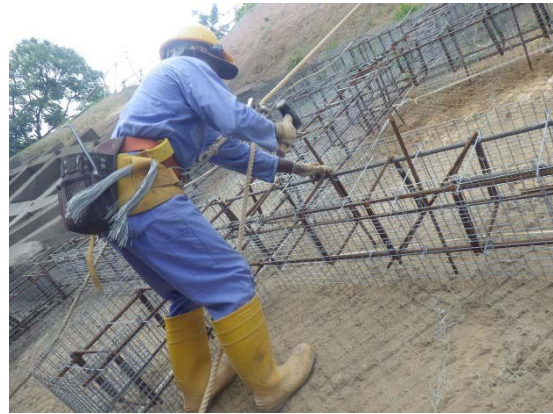
写真 28 ユニット式金網型枠の組立
