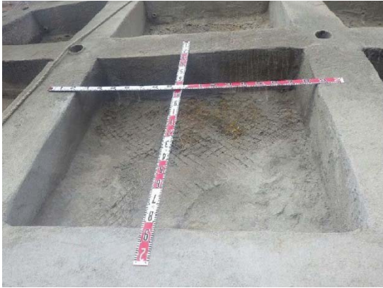
写真 31 法枠の出来形寸法の確認
