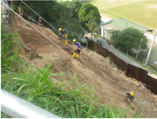
写真 25 法面の人力整形
