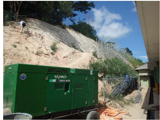
写真 20 上部斜面の工事
