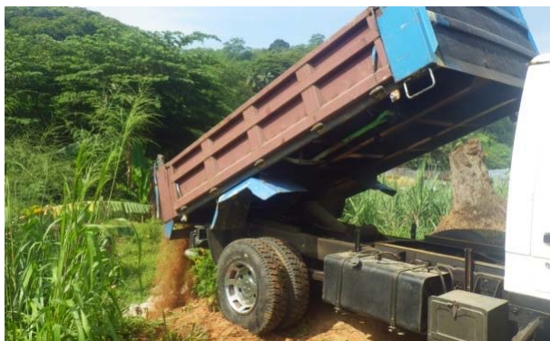
写真 65 残土処理状況
