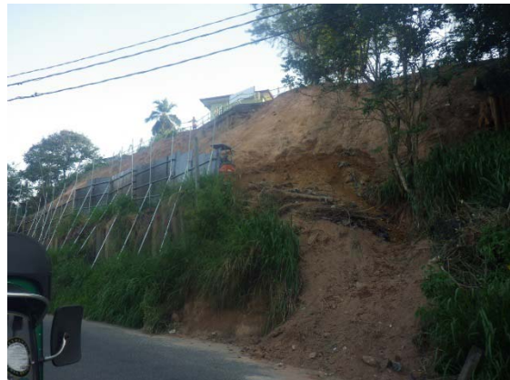
写真 22 整形後の対象サイト（起点側）
