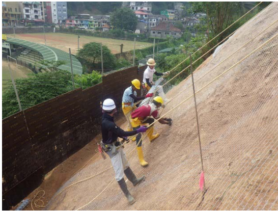
写真 27 ひし形金網の敷設
