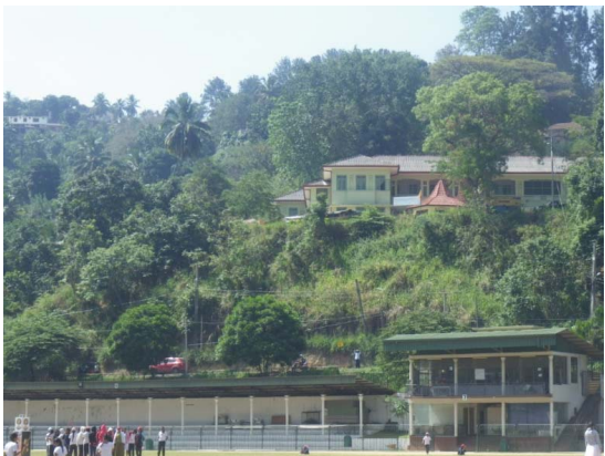
写真 3 工事対象斜面 (2017 年 1 月)
