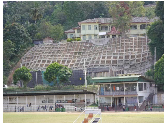
写真 34 工事完了後全景
