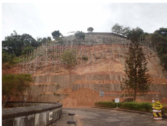
写真 58 ヴィクトリアダムの法面对策
