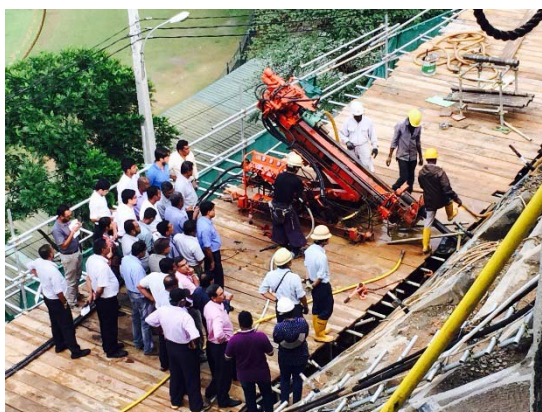
写真 50 削孔作業①
