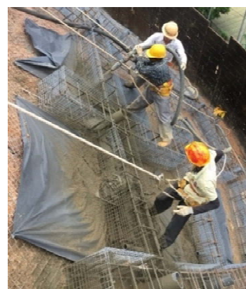
写真 48 モルタルの吹付状況
