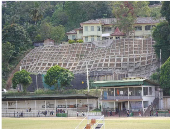
写真 8 実証試験工事完成 (2018 年 2 月)
