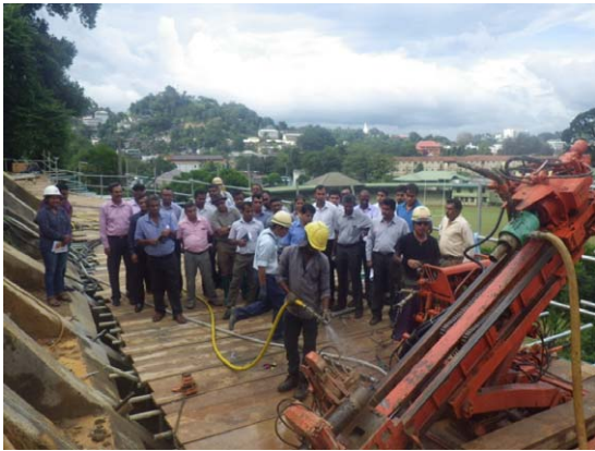
写真 51 削孔作業②
