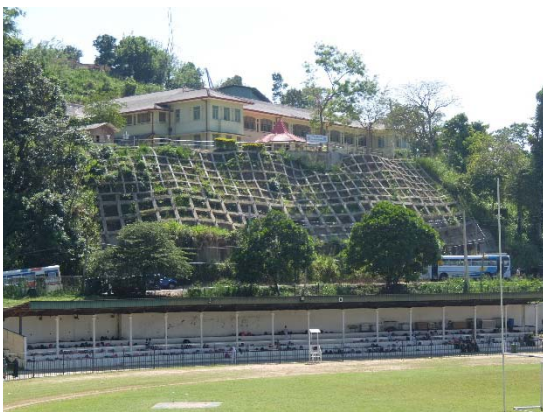
写真 11 実証試験工事の現状 (2019 年 3 月)
