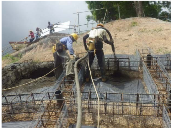
写真 30 モルタルの吹付
