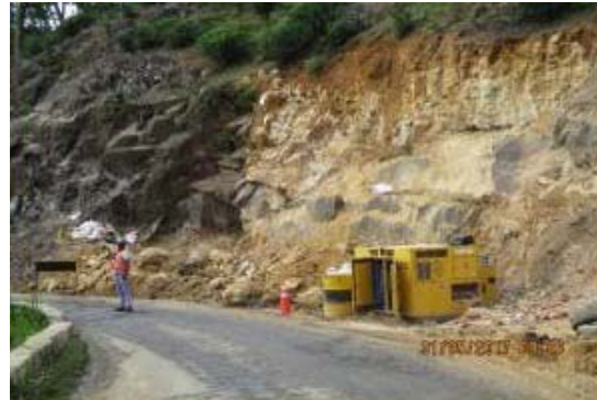
写真 63 Badulla における道路整備工事
