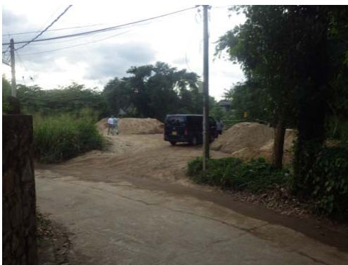
写真 64 残土処理場全景
