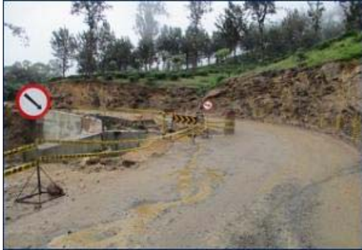
写真 62 Badulla における道路整備工事
