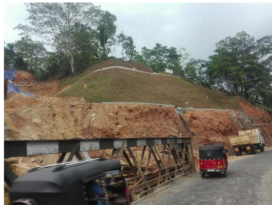
写真 61 Giniathena 地区の法面对策②
