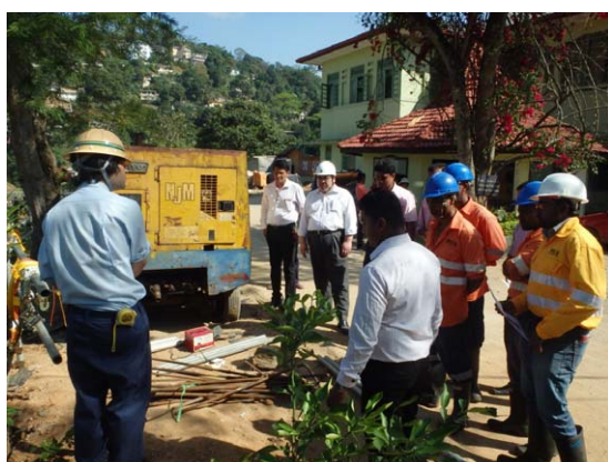
写真 41 法面作業の説明状況
