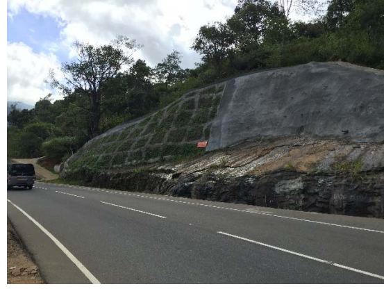
写真 16 鉄筋挿入工(左)・モルタル吹付工(右)
