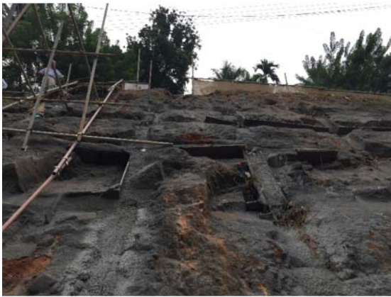
写真 17 鉄筋挿入工、頭部連結工
