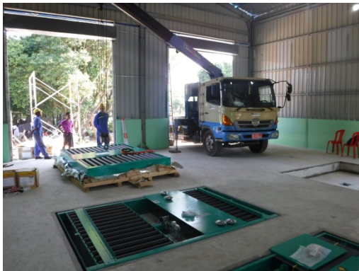
自動車検査機器搬入 (2017年11月)
