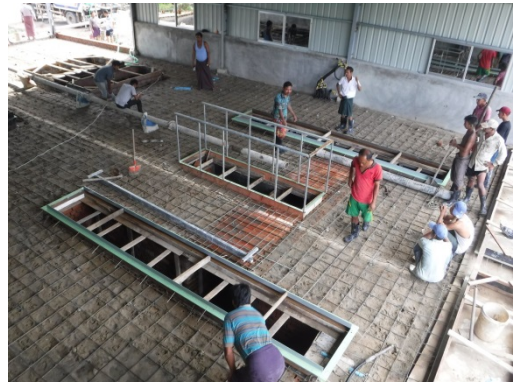
基礎工事 (2017年9月)
