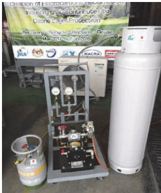
ポンプを用いた冷媒の移し替え
