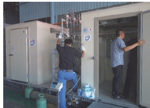
稼働確認の実施 (2017年7月)
