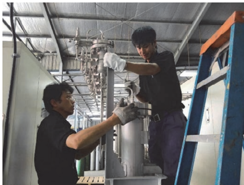
再生機設置作業 (2017年7月)
