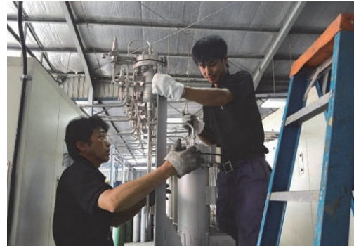
再生機の設置作業 (2017年7月)
