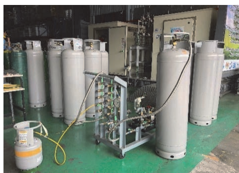
冷媒の移し替え（小型容器から大型容器へ） （2018年3月）
