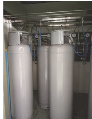
再生の様子 (冷却室)
