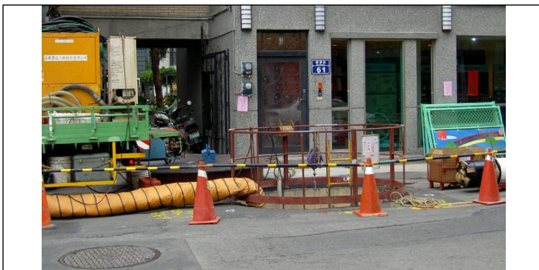
図 2-1 狭隘な道路での小口径推進工事
