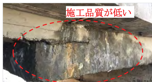
ゲルバーヒンジ部の剛結化による補修の状況
