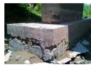
骨材との材料分離による強度低下(カンボジア)
