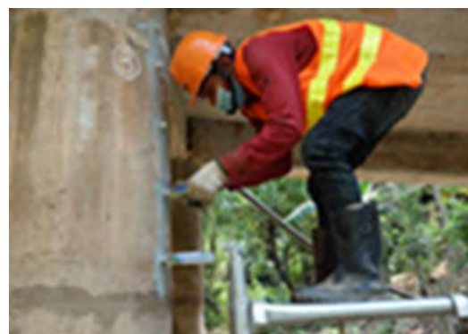
ひび割れ注入工 (カンボジア)
