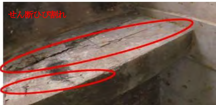
図 2-33 過積載車両の通行による上部工の損傷の事例（カンボジア）
