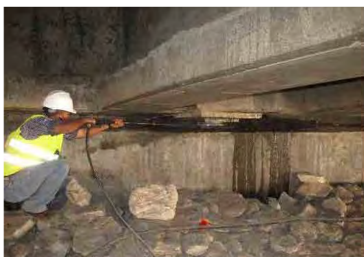
高圧洗浄機による支承周りの清掃 (エジプト)
