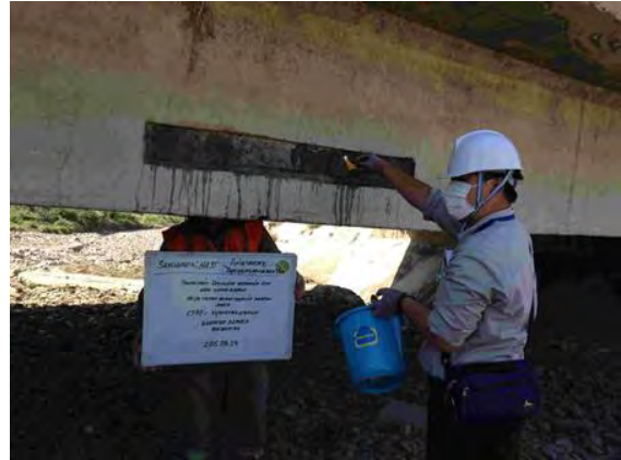
ポリマーコンクリートによる断面修復（モンゴル）
