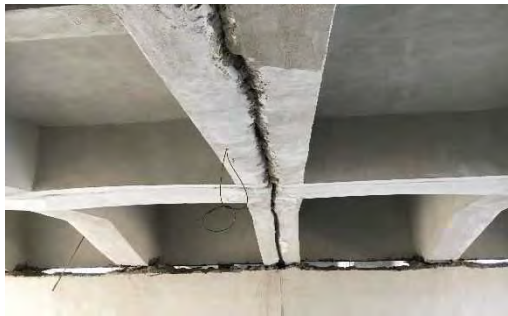
桁下、床板下面は全面的に Shotcrete 補修
