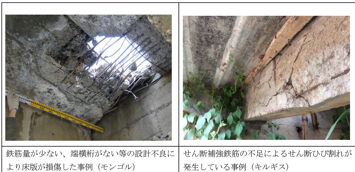
図 2-6 不適切な設計が原因で機能が低下している事例
