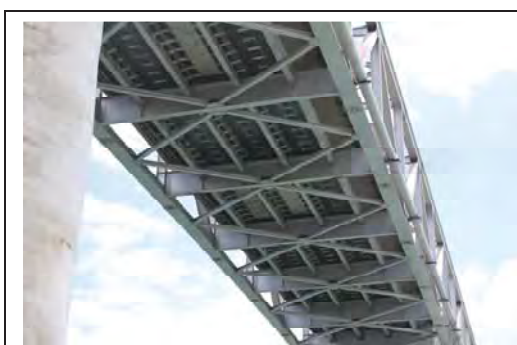
1st-Mandaue Mactan Br. 鋼I桁および鋼トラス部材の再塗装
