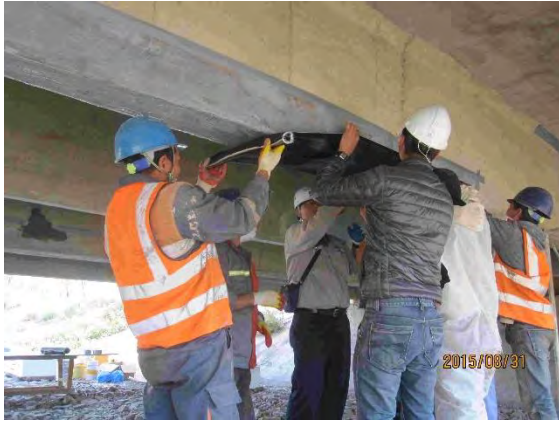
炭素繊維シートによる主桁の補強（モンゴル）
