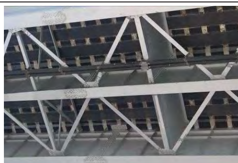
1st-Mandaue Mactan Br. 床版下面の炭素繊維シート補強
