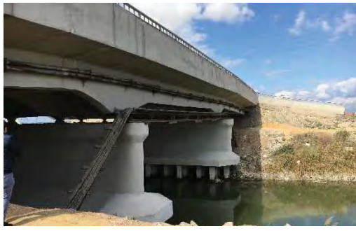
補修橋梁の全景
