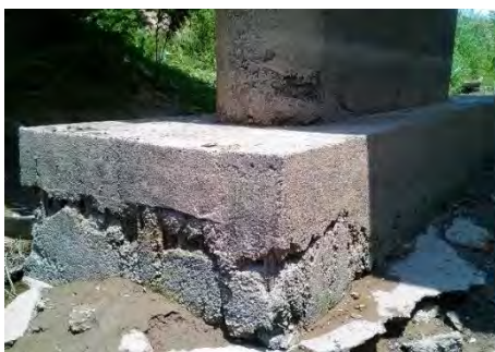
骨材との材料分離による強度低下（カンボジア）
