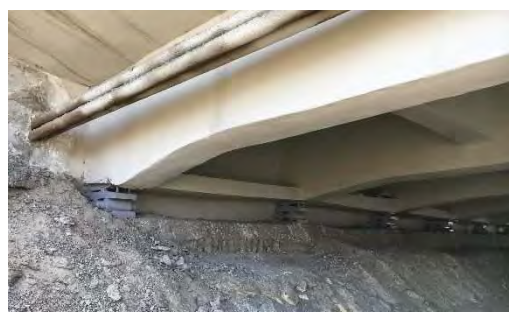
支承は清掃後、ジンクリッチペイントで防錆
