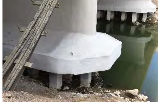
杭頭部についても一部補強が行われた
