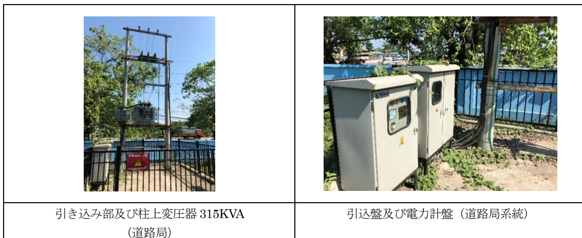
図 2-38 道路局用受変電設備の現況
