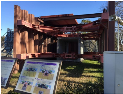
⑨屋外展示場：施工プロセス紹介コーナー
