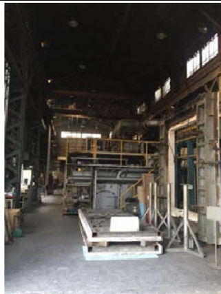
⑰防耐火構造試験棟
