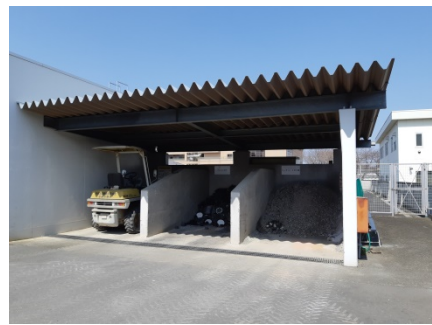
⑱別棟横：廃材置き場
