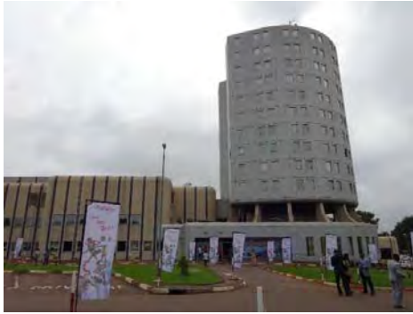
写真-1：CRTV 施設外観
