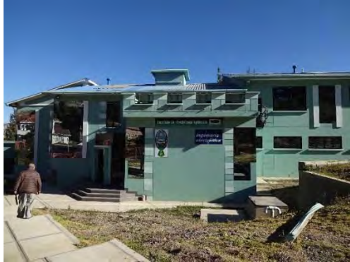
写真-1:IEA 建物外観
