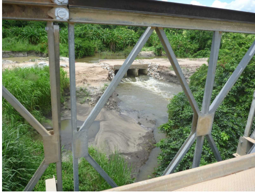
写真-7 ムエラ II 橋 2019 年、上流部に大型車両走行のためのカルバートが設置された。
