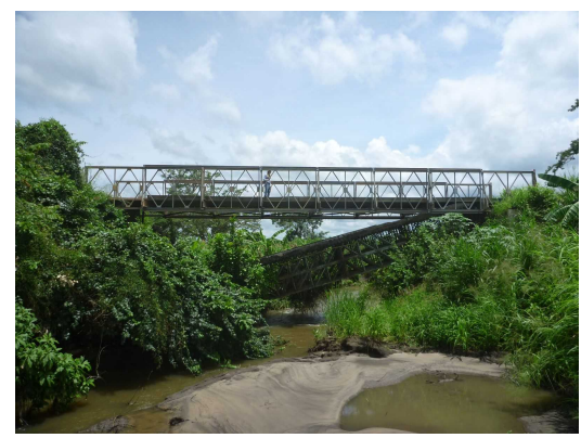
写真-6 ムエラ II 橋 2019年に既設トラス橋が落橋し、ベイリー橋が設置された様子を示す。
