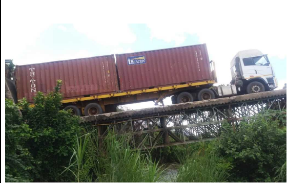
写真-8 ムエラ II 橋 2019 年、大型トレーラ通過時に落橋した際の状況を示す。
