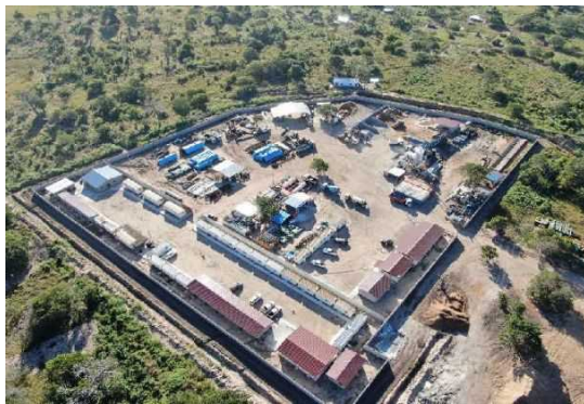
写真-11 キャンプヤード 過年度案件のキャンプヤードでは安全確保のため高さ 2.5m のコンクリート壁による外壁工が設置された。
