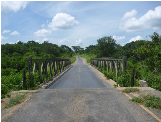
写真-9 ムンゴエ橋 道路線形の様子とベイリー橋正面の様子を示す。
