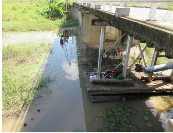
仮設桁、仮設橋脚の様子
