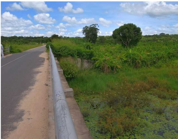
橋台側面(上流側)
