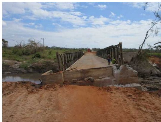
写真-3 ムアガムラ橋 2019年のハリケーンにより橋台が傾斜し、通行不能となった際の様子を示す。
