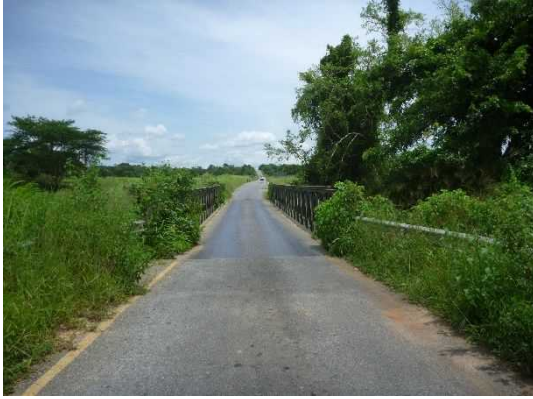
写真-1 ムアガムラ橋 道路線形とベイリー橋の正面の様子を示す。
