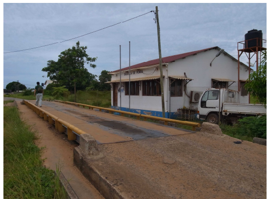
写真-12 車両重量計測施設 国道 380 号線の南部側に位置する車両重量計測施設を示す。
