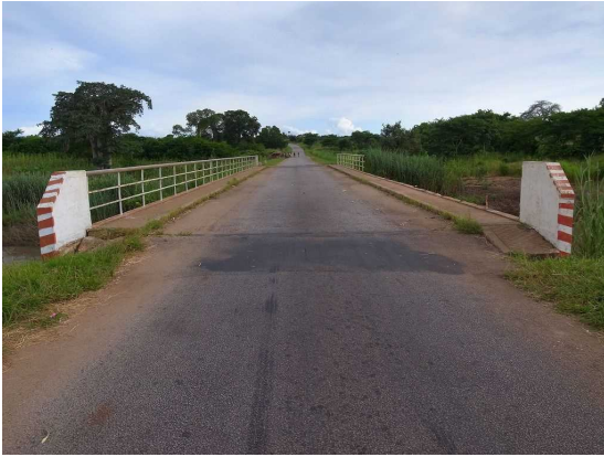
Muaguide 橋 (一部高欄がない)
