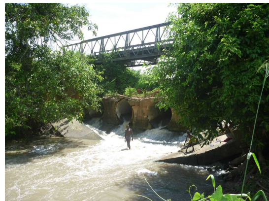
写真-10 ムンゴエ橋 パイプカルバートが沈下、崩壊し、ベイリー橋により供用している様子を示す。
