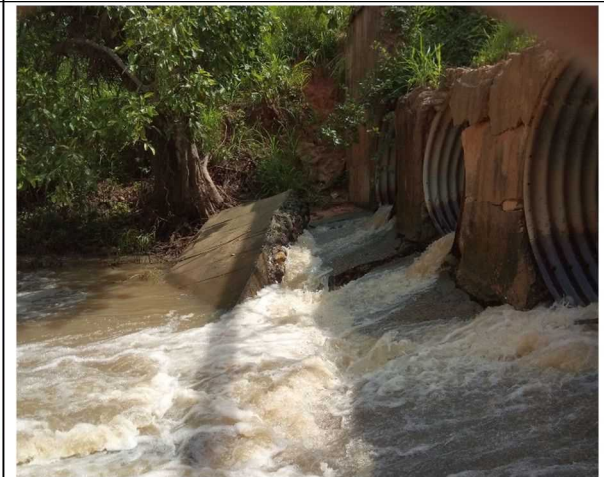
下流側のアウトレット部での河床変動
