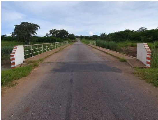
Muaguide 橋（一部高欄がない）
