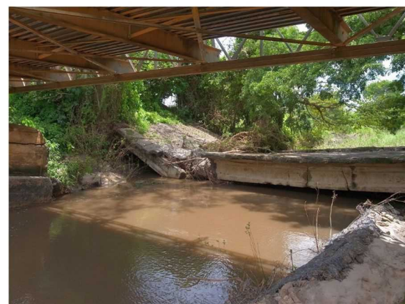
下流側の既設橋
