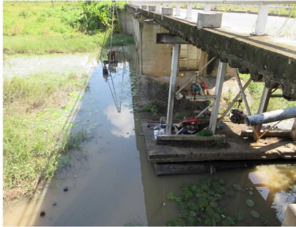
仮設桁、仮設橋脚の様子
