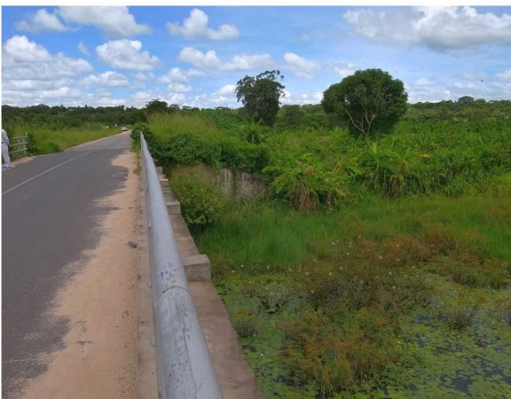
橋台側面(上流側)
