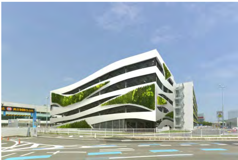
図 6.3 大和ハウスの大気浄化壁面緑化システムの利用イメージ
