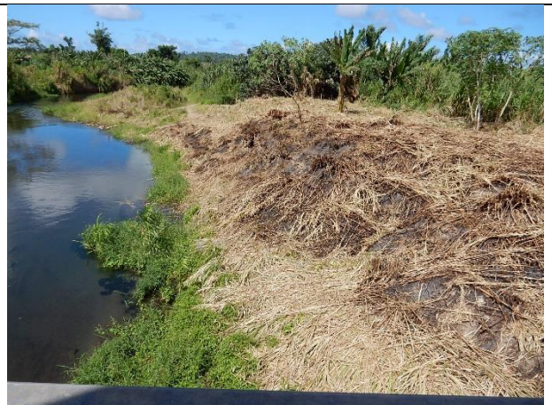
テオウマ橋下流部右岸の状況
