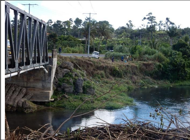
テオウマ橋上流部右岸の状況
