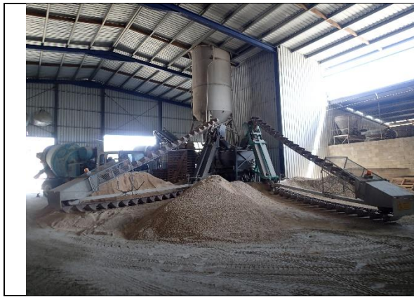
稼働中の生コン工場
