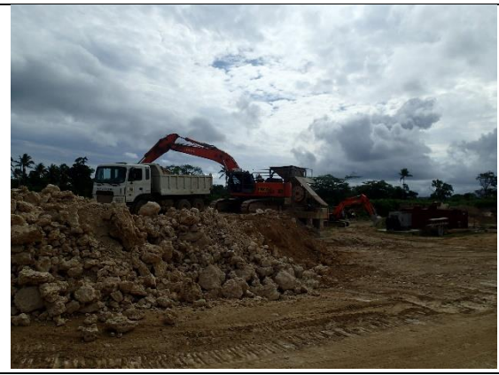
碎石採取場稼働状況
