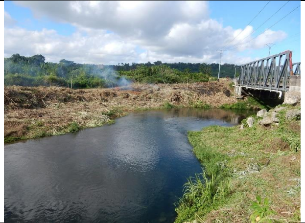
テオウマ橋上流部左岸の状況
