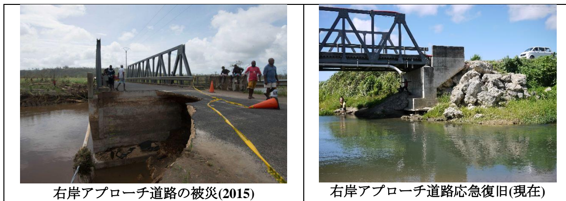
図 3.2-10 2015 年のサイクロン「パム」による橋梁被災状況
