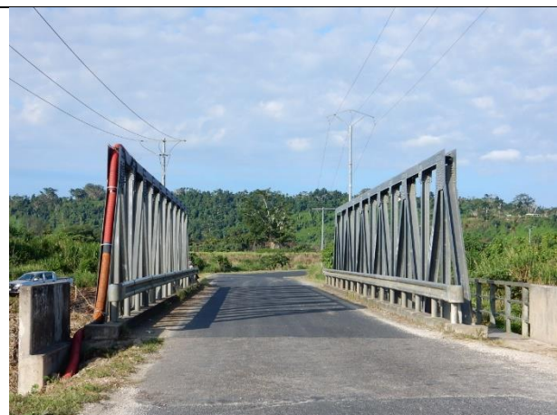
テオウマ橋の上部工の状況 (ポートビラ側から)
