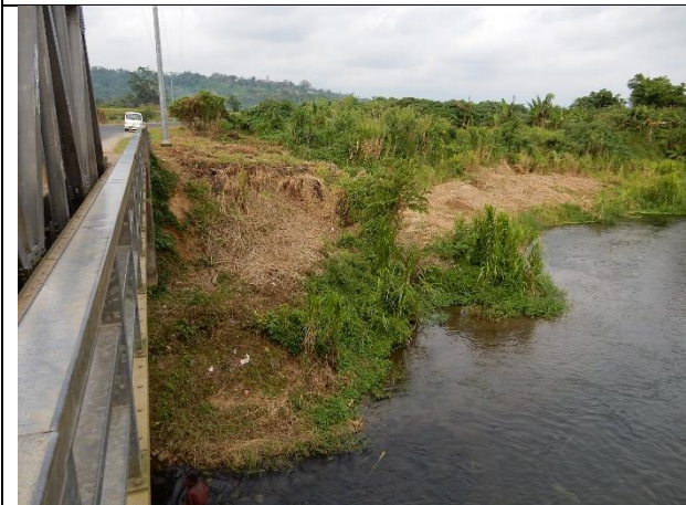
テオウマ橋下流部左岸の状況
