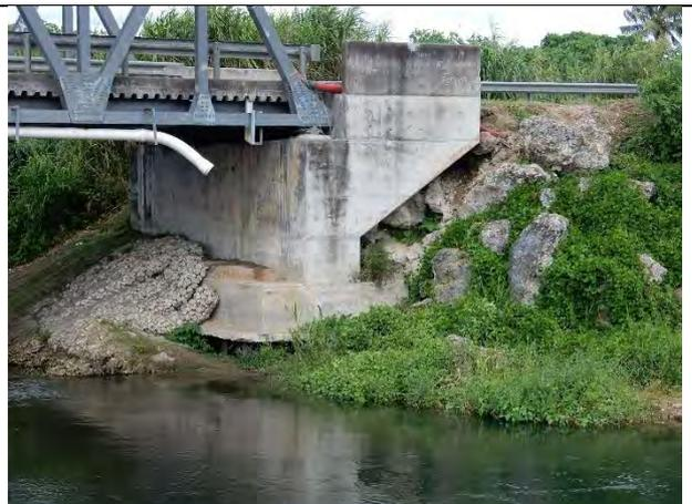
テオウマ橋右岸の橋台取付部の損傷部に対する応急措置、橋台保護の蛇籠は流失
