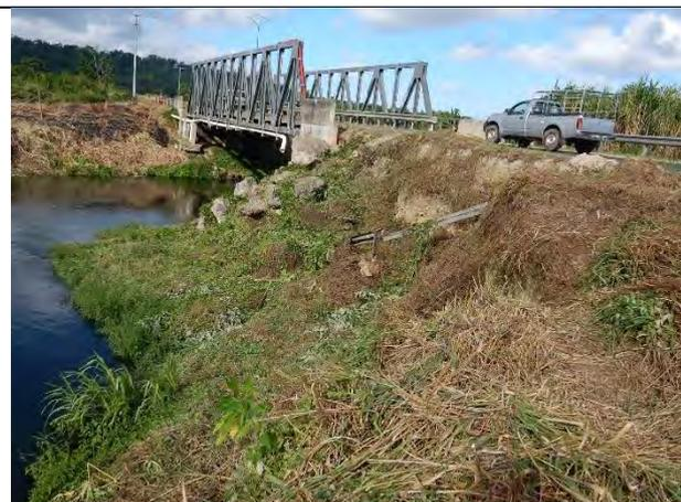
テオウマ橋上流部の右岸の洗掘状況／ガードレール損傷
