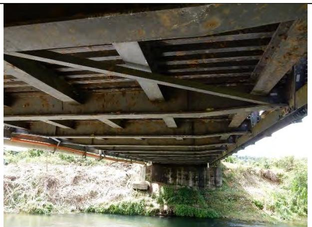
テオウマ橋の上部工の状況／氾濫により土が付着している。
