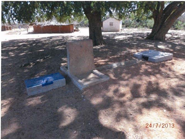
新設／共同水栓 1 と量水計、排水柵 (2013 年 7 月 24 日)
