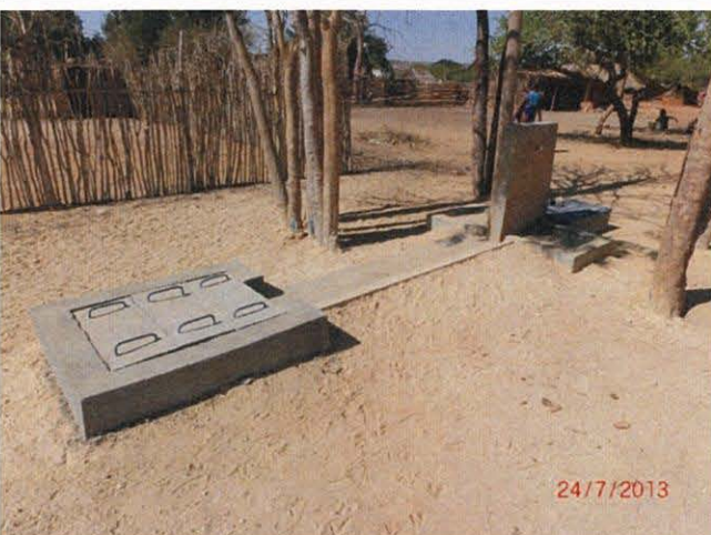
改修後／共同水栓 5 と排水柵、量水計 (2013 年 7 月 24 日)
