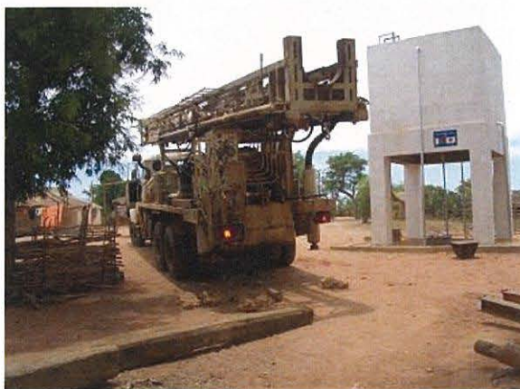
掘削機械 TOP500 掘削位置に設置状況 2013年12月31日
