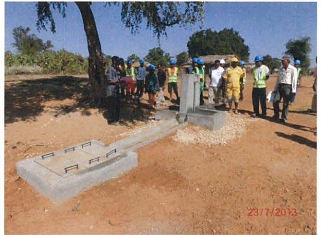
新設後／共同水栓 4 と排水柵（2013 年 7 月 23 日）
