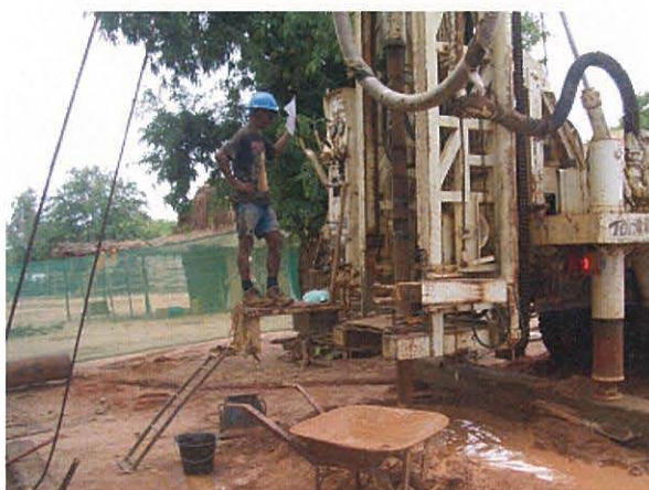
サーフェース(地表部)泥水掘削 2014年1月11日
