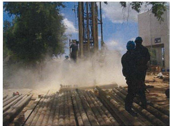
掘削状況 2014年2月4日
