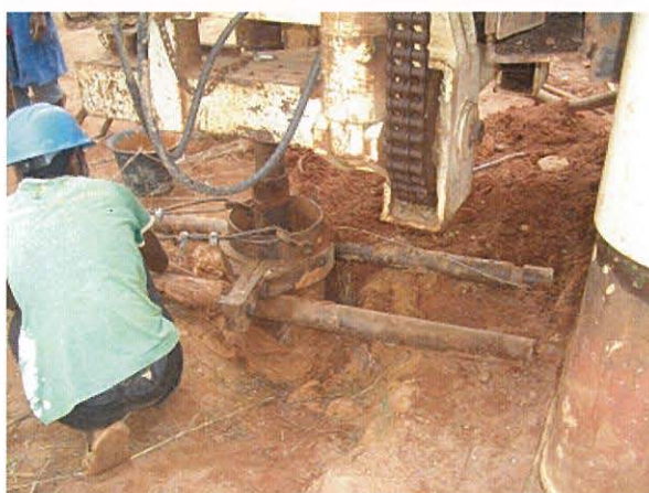
A300 口元ケーシング挿入とセット状況 2014年1月17日
