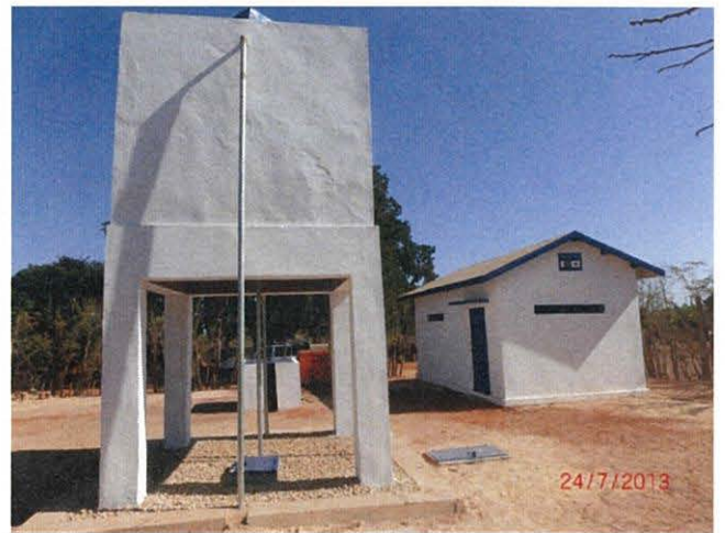
改修後／高架水槽および発電機室 （2013年7月24日）
