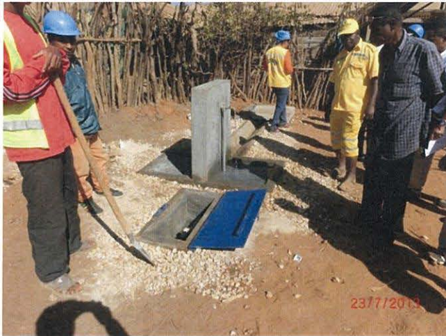
新設後／共同水栓 3 と量水計（2013 年 7 月 23 日）
