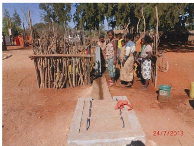
改修後／共同水栓5と排水柵 (2013年7月24日)
