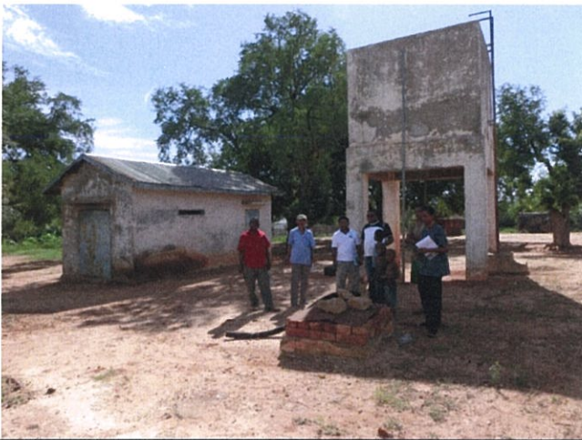
改修前／発電機室及び高架水槽（2013年3月7日）
