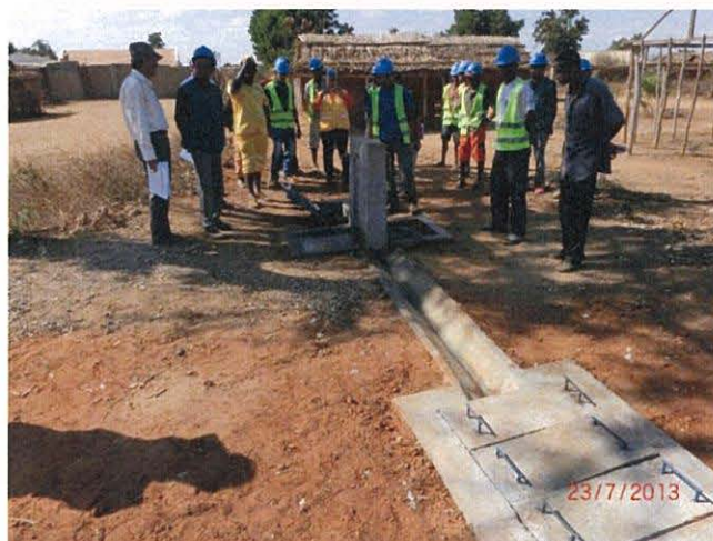
改修後／共同水栓 10 と排水柵（2013 年 7 月 23 日）
