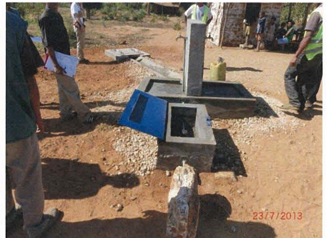
改修後／共同水栓 7 と量水計、排水柵 （2013 年 7 月 23 日）
