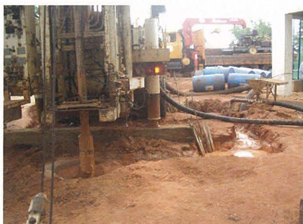
サーフェース(地表部)泥水掘削 2014年1月11日
