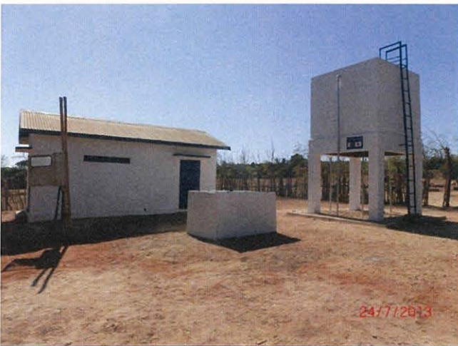
改修後／高架水槽、発電機室および 井戸頂部樹（2013年7月24日）
