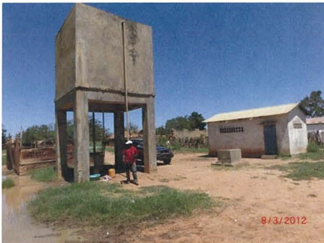
改修前／高架水槽（2013年3月8日）
