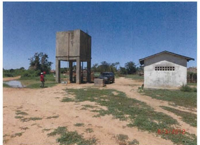
改修前／発電機室（2013年3月8日）
