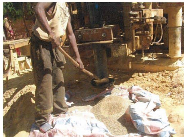
ケーシング周囲へのグラベル挿入状況 2014年3月13日
