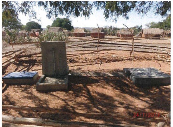
新設／共同水栓 2 と量水計、排水柵 (2013 年 7 月 24 日)
