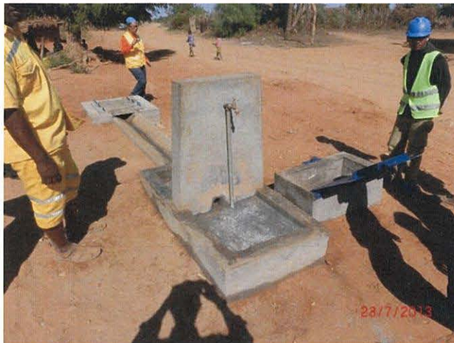
改修後／共同水栓 6 と量水計、排水柵 （2013 年 7 月 23 日）
