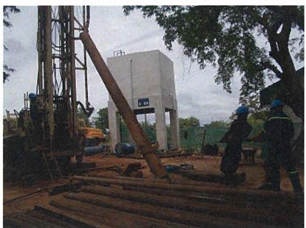
A300 口元ケーシング挿入とセット状況 2014年1月17日
