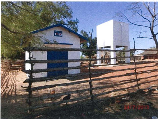
改修後／発電機室と高架水槽（2013年7月24日）
