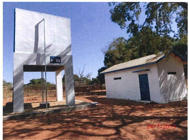
改修後／高架水槽と発電機室（2013年7月24日）
