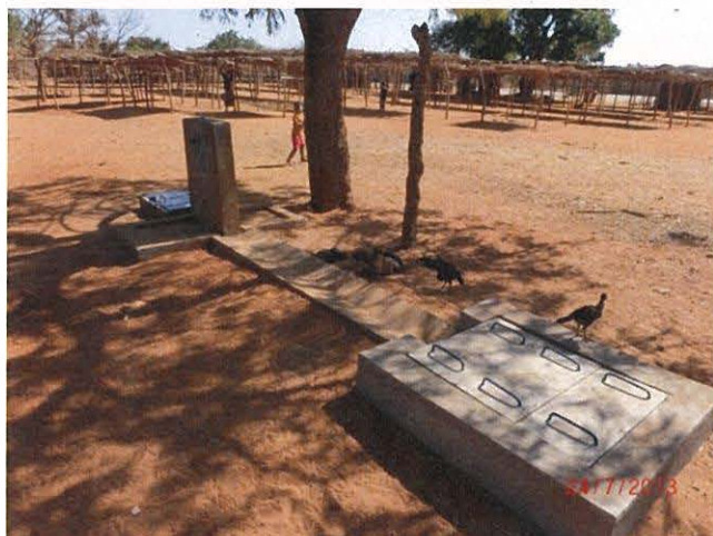
改修後／共同水栓 3 と排水柵、量水計 (2013 年 7 月 24 日)
