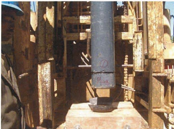
掘削（290m）完了後ケーシング挿入開始 2014年3月12日
