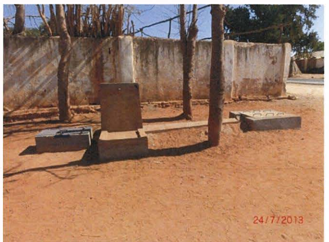
改修後／共同水栓 4 と量水計、排水柵 (2013 年 7 月 24 日)
