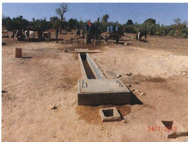
改修後／高架水槽排水浸透柵と牛の水飲み場 (2013年7月24日)
