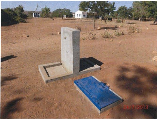
改修後／共同水栓 7 と量水計（2013 年 7 月 24 日）
