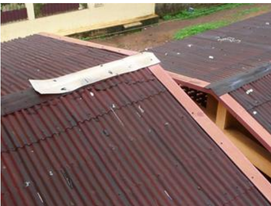
校長室 屋根 補修
