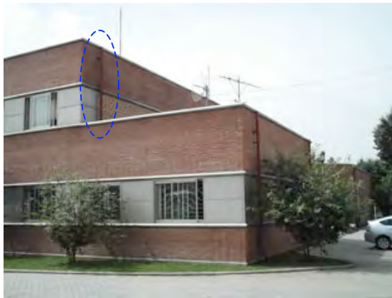
写真⑰：2階屋上雨水の1階屋上放流用竖樋
