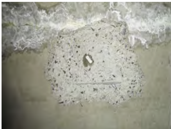
写真③：2階ジャパンプラブ室の漏水による白濁
