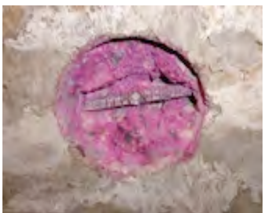
写真③⑤：2階ジャパンクラブ上部中性化検査
