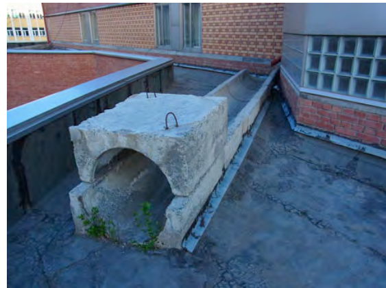
写真⑱：1階屋上の既存U字型排水路
