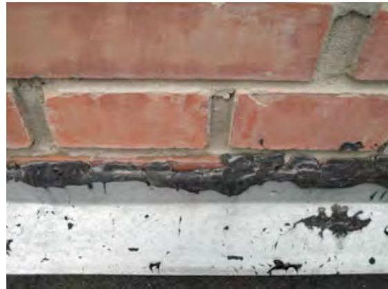
写真⑯：フラッシングの取付け位置とコーキング
