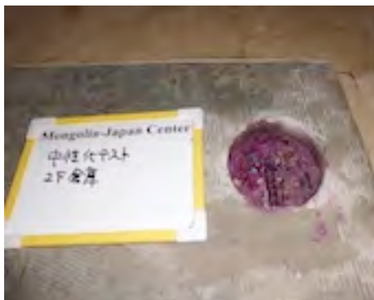
写真③⑥：2階倉庫床中性化検査
