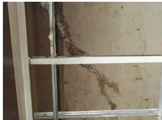
写真③：2階ジャパンプラブ室の漏水による白濁
