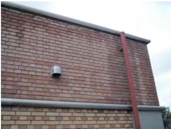
写真⑲：白華現象によるレンガ表面の汚れ
