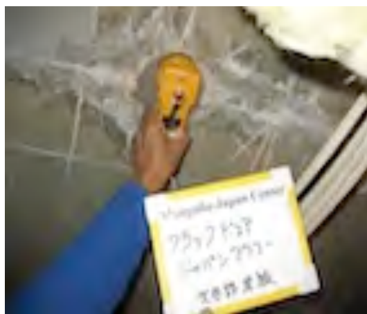
写真③④：ジャパンクラブ室上部クラック検査
