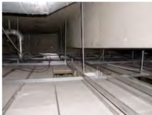
写真②⑥：同左上部梁の撓み検査状況
