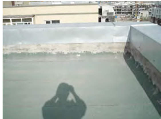
写真㉓：市内マンションの屋上状況
