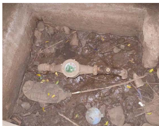
図 2-13 既存公共水栓 No.4 の弁室
