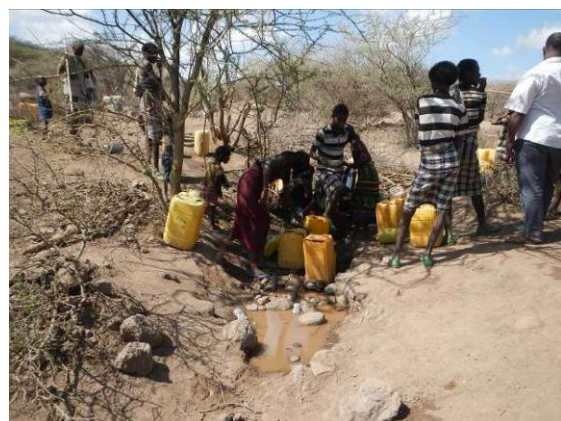
図 2-57 送水管漏水箇所
