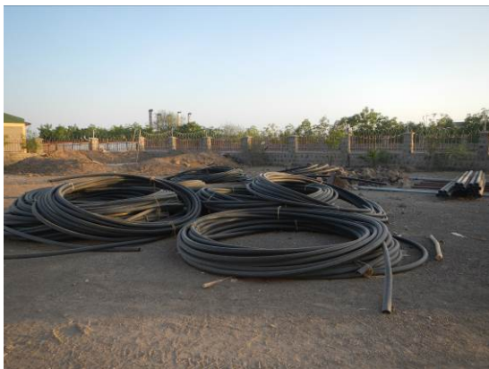
図 2-2 資材置き場の HDPE 管
