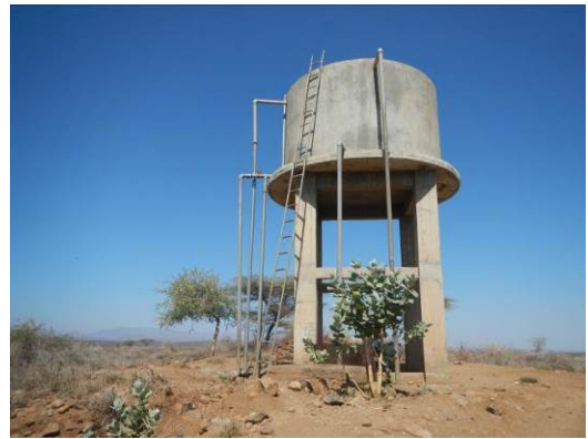
図 2-37 既存高架水槽
