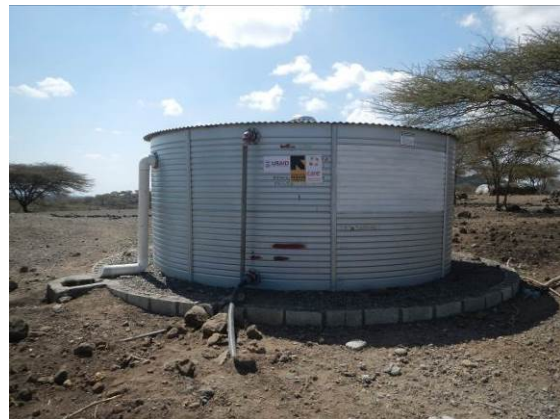
図 2-51 他ドナーによって建設された配水池
