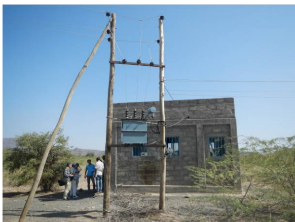
写真 3 : 先方政府により 2015 年に電化された井戸運転施設 (グビドゥラ)
