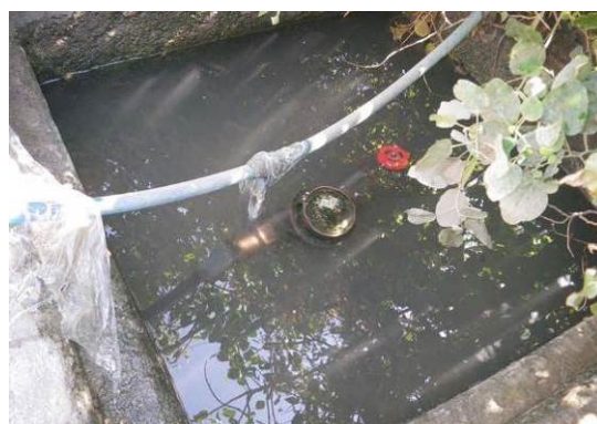
図 2-10 既存公共水栓 No.1 の弁室
