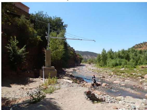
Photo 1.1.1 Jauge des Niveaux d'Eau (Juillet 2013)
