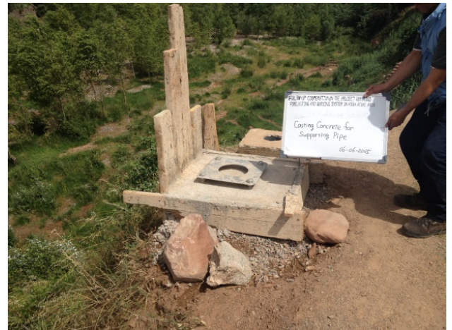
6 juin Coulage du béton pour les mats en acier du câblage en hauteur
