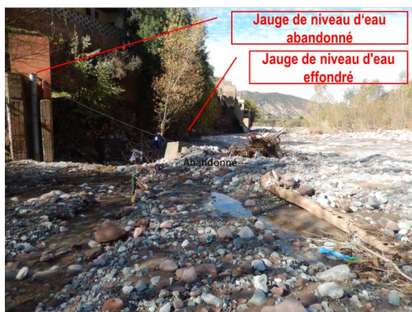
Photo 2.3.1 Emplacement du site de Reconstruction
