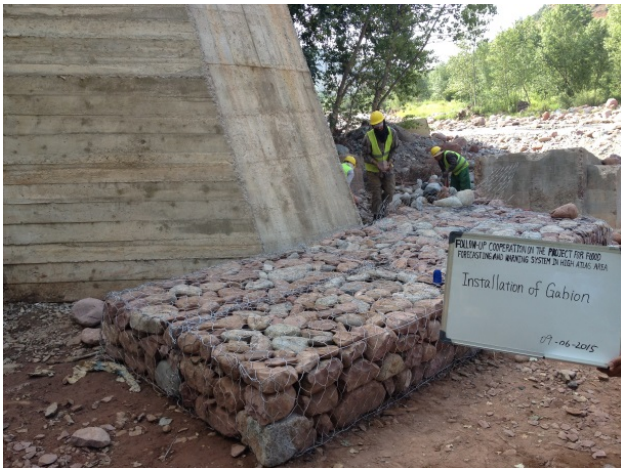
9 juin Mise en place de gabion
