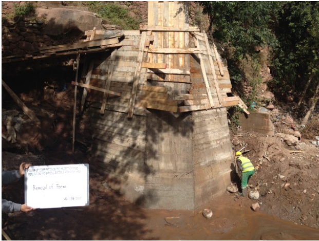
4 juin Enlèvement du coffrage (en partie)
