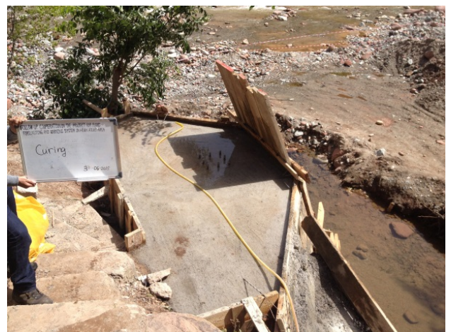
3 juin Cure de béton
