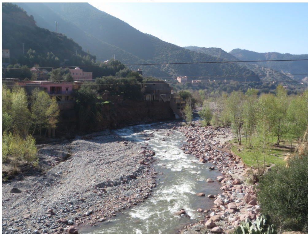
vue panoramique 1 (avant le commencement des travaux)
