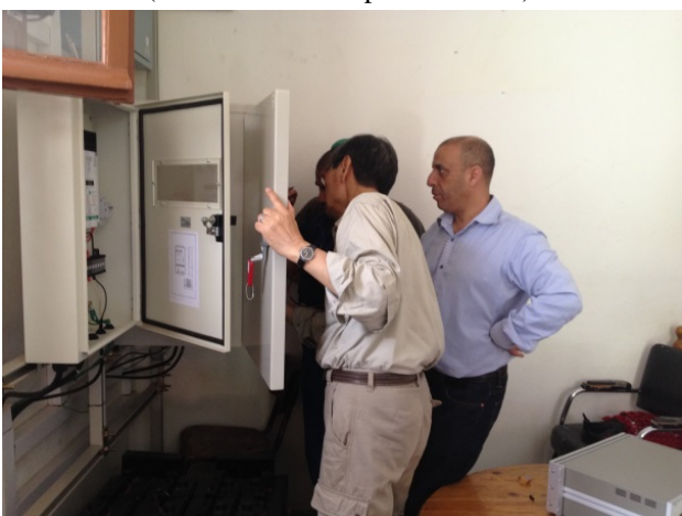
11 juillet Installation de l'enceinte principale de la jauge du niveau d'eau
