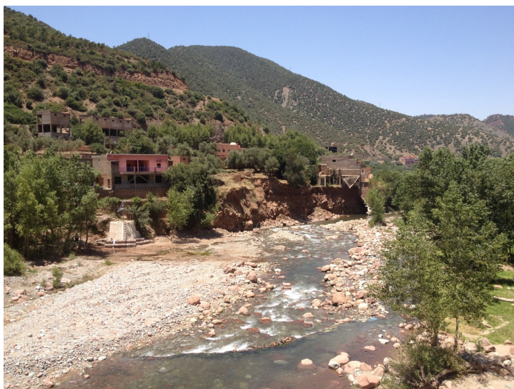
vue panoramique 2 (après le commencement des travaux)
