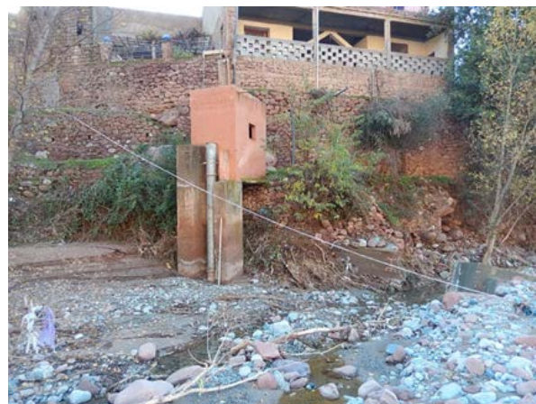
Photo 2.3.2 Jauge des Niveaux d'Eau Abandonnée
