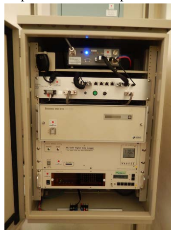
11 juillet Achèvement de l'installation de l'enceinte principale de la jauge du niveau d'eau
