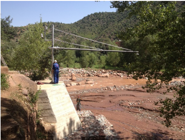
9 juillet Installation du transducteur et transmetteur du thermomètre
