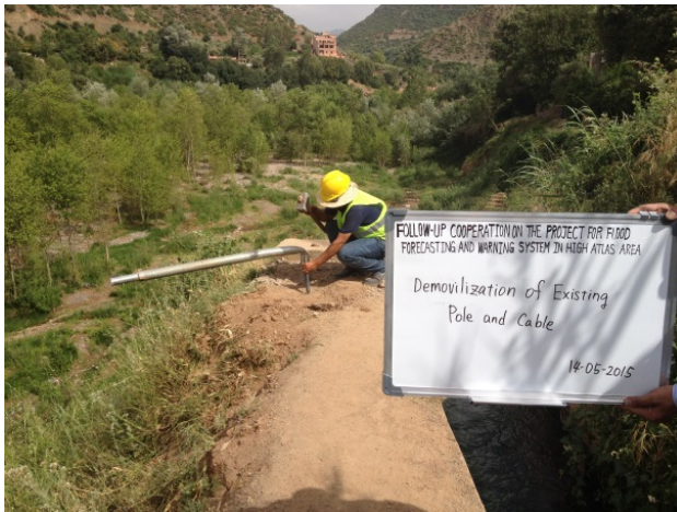
14 mai Enlèvement des mats en acier endommagés pour le câblage en hauteur
