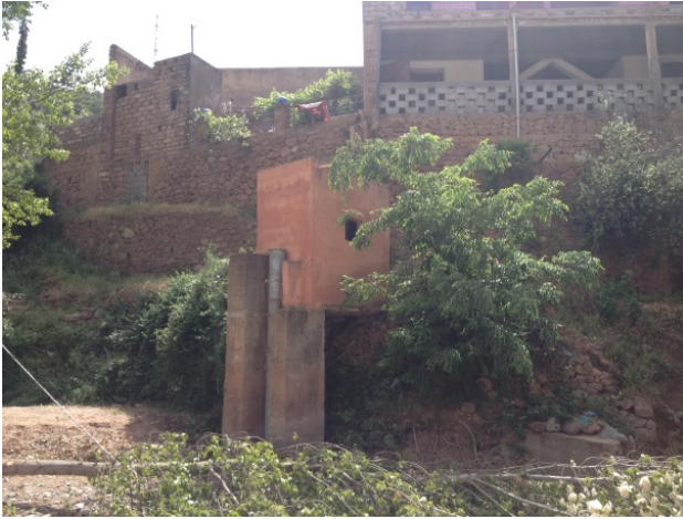
Avant le commencement des travaux
