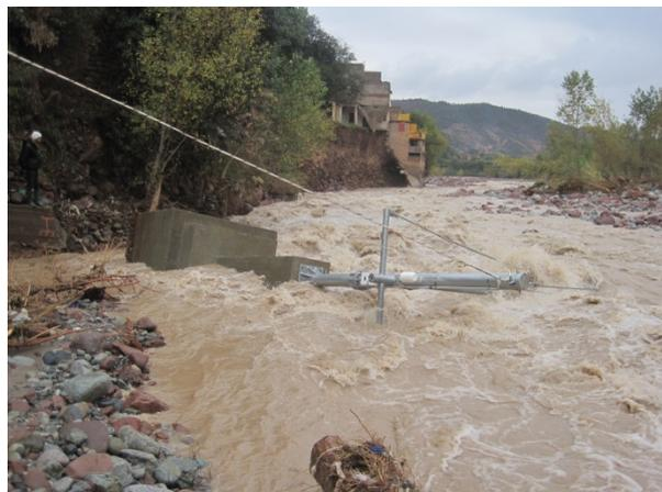
写真 2.1.1 水位計が倒壊した 2014 年 11 月 24 日撮影の写真
