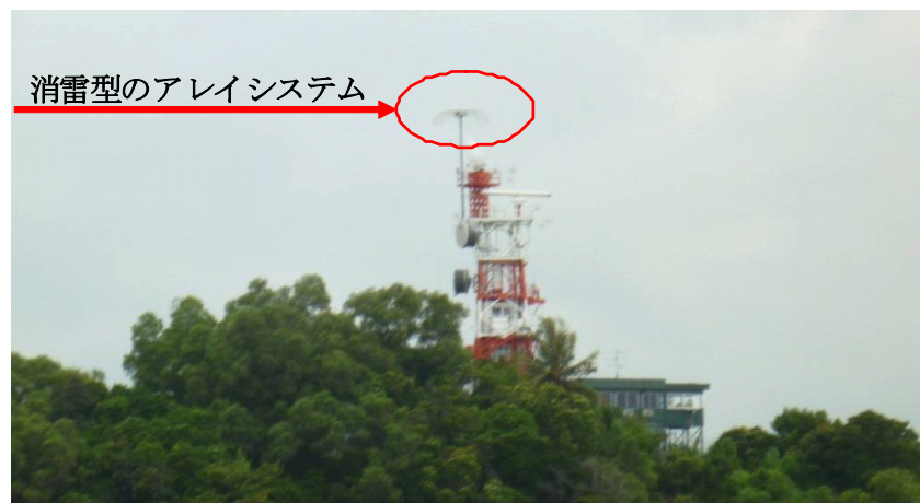
写真 2-10 : シンガポール MPA VTS 局 消雷型のアレイシステム (日立製)
