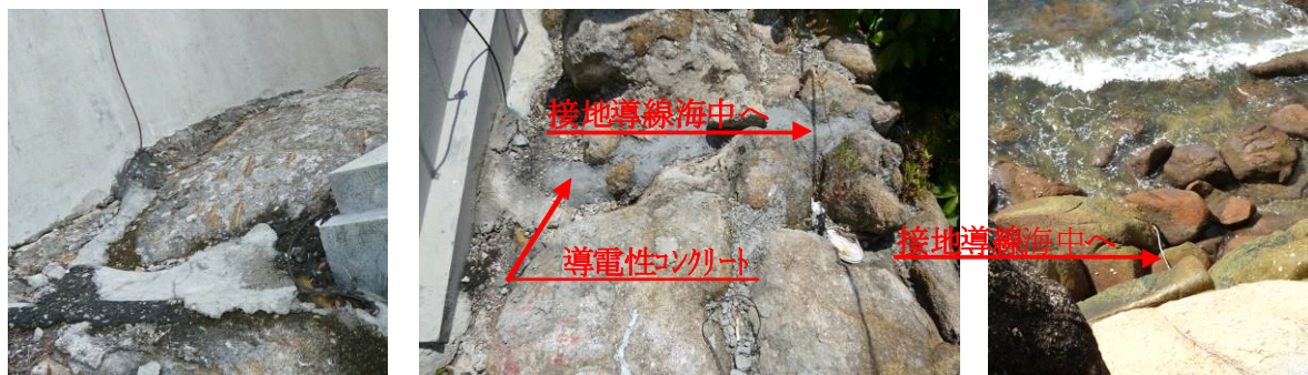
(1) 接地線保護状況 (2) 接地線保護状況 (3) 海中接地（仮設）の状況
