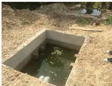
アタ養殖場のホルモン沈殿槽
