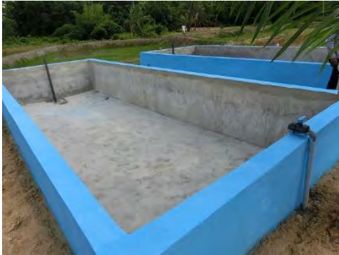
コンクリートタンク 2 基
