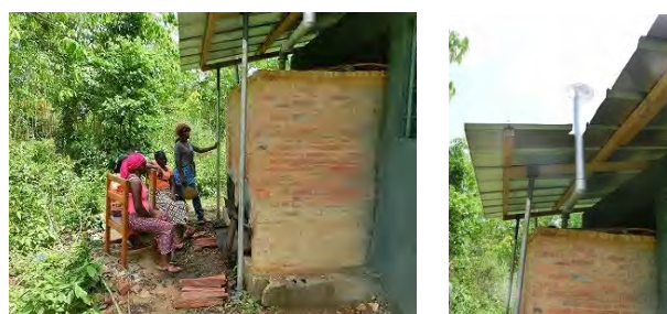
火入れの様子
