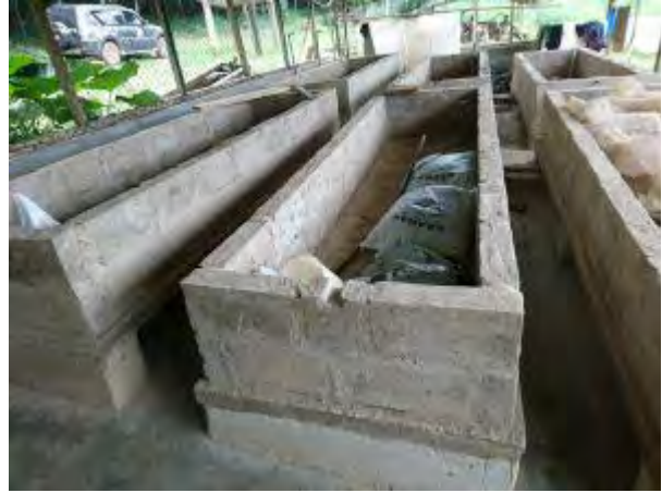
増設したコンクリート水槽
