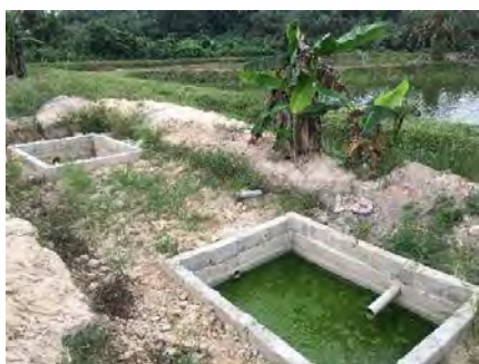
ミラン養殖場のホルモン沈殿槽
