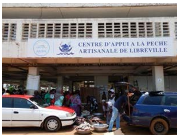
Le panneau renouvelé du côté du quai
