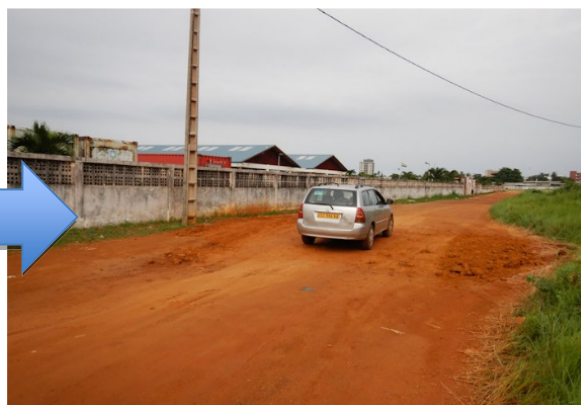
Après les travaux de réfection (février 2018)
