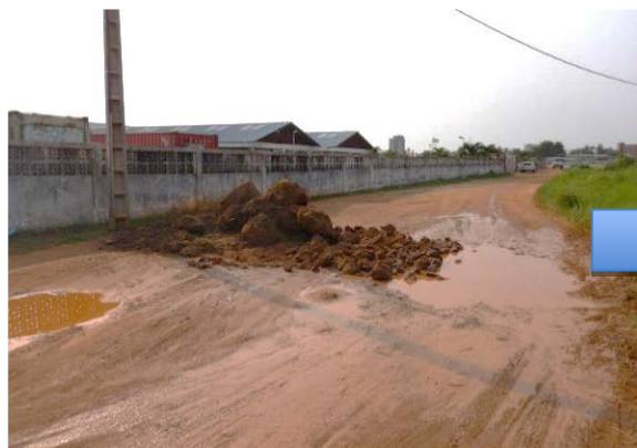
Terre et pierres transportées pour les travaux
