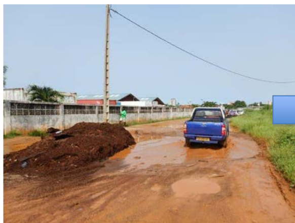
Devant le portail principal du CAPAL (janvier 2019). De nouveaux trous se sont formés au niveau de la route. Une tentative a été effectuée pour combler ces trous avec des déchets de bois mais sans résultat significatif.
