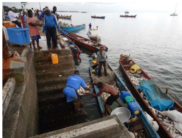
CAPAL 棧橋の外海側。干潮時は階段を利用して水揚げする。ただし、荒天時は波が高いため棧橋の内側を利用する。
