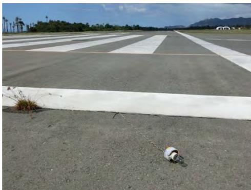
滑走路 08 端と欠落した末端灯
