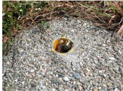
滑走路灯火（灯具が欠落した箇所）
