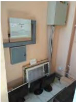
機械室に設置されている窓タイプと壁掛け空調機
