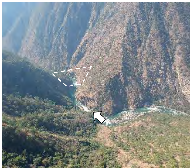
Photo 1 下部ダム地点 (PSPP 専用)
