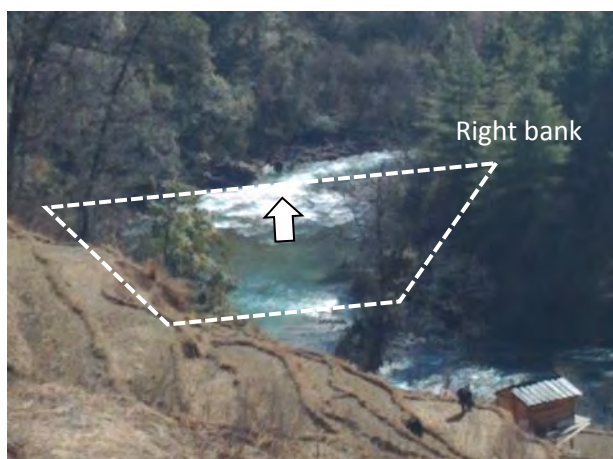
Photo 1 ダム地点_Rev3 (高さ : 60m) (右岸の基礎岩盤が確認できない)
