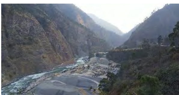
Photo 3 ダム地点 下流側
