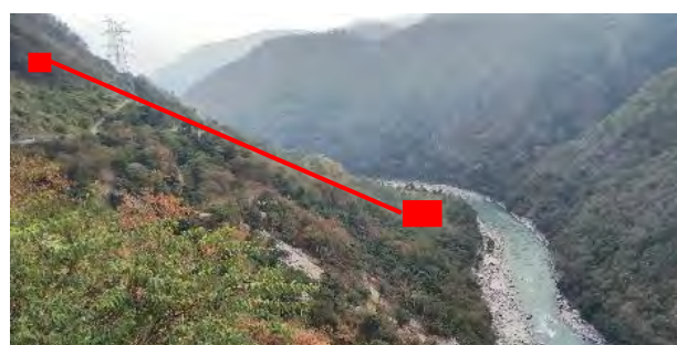
Photo 6 サージタンクおよび発電所地点
