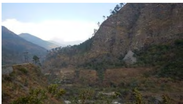
Photo 1 ダム地点 左岸
