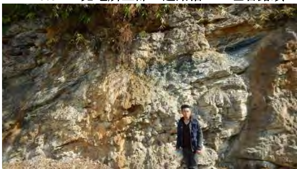
Photo 4 熱水変質により脆弱化した地層
