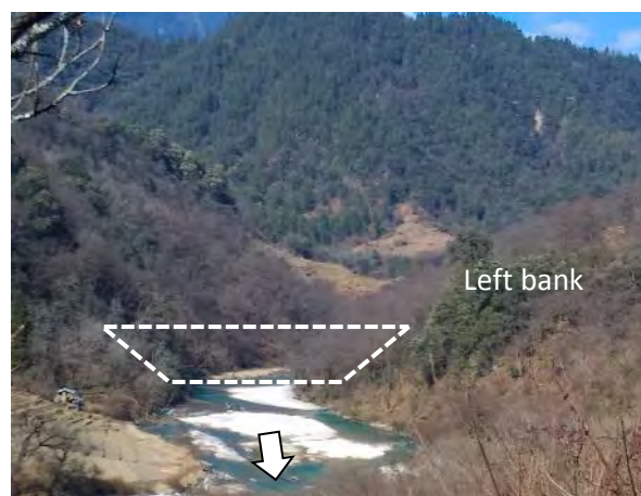
Photo 2 最終ダム地点 (高さ : 30m)
