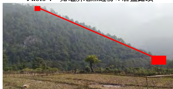
Photo 6 サージタンクおよび発電所地点
