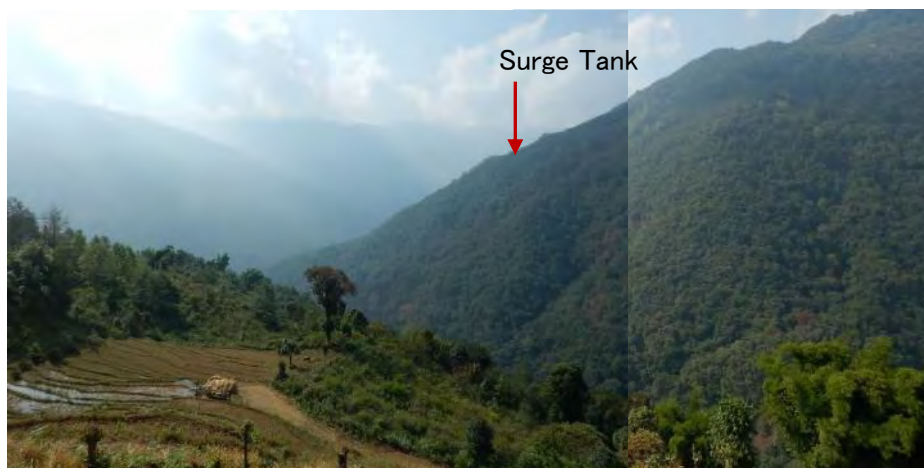
Photo 4 A-5_Rev サージタンク地点周辺の遠望
