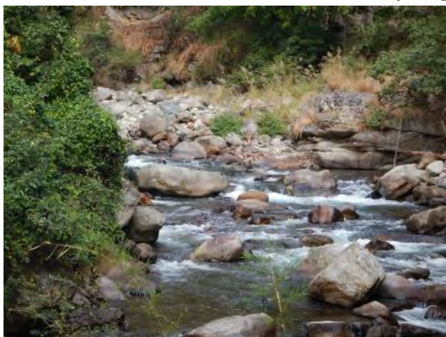
Photo 4 ダム下流 200m地点の河床
