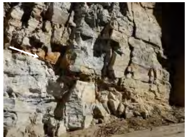
Photo 5 節理卓越 (下流傾斜) ゾーン
