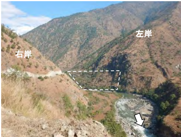
Photo 1 変更ダム地点
