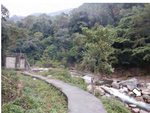
Photo 9 既設ミニ水力発電所
