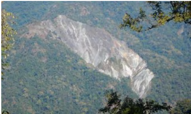
Photo 5 ダム地点より 4.5km 上流の熱水変質による大規模崩壊地
