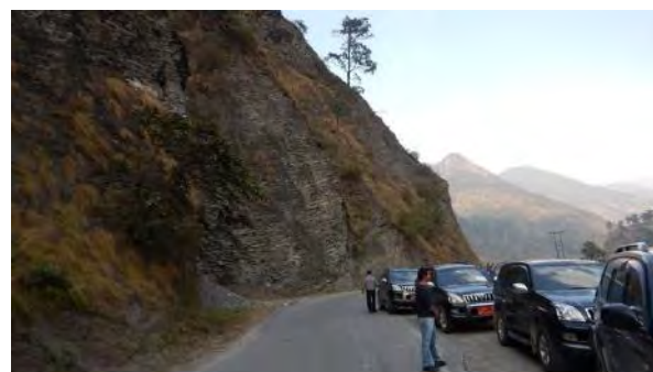
Photo 2 ダム地点 右岸
