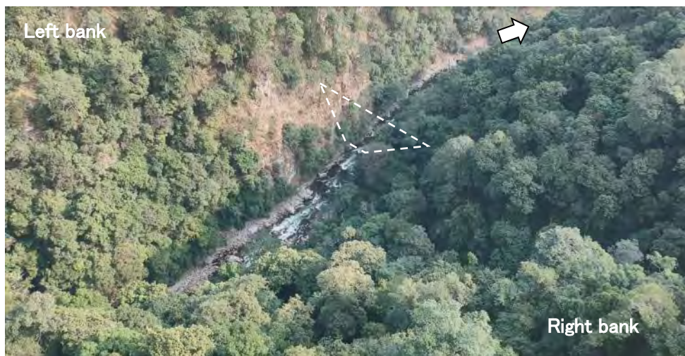
Photo 3 ダム地点 (1) 上空より
