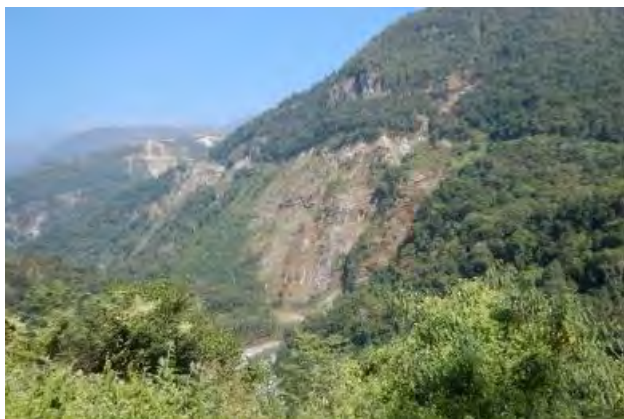
Photo 1 片麻岩露頭 (左岸)
