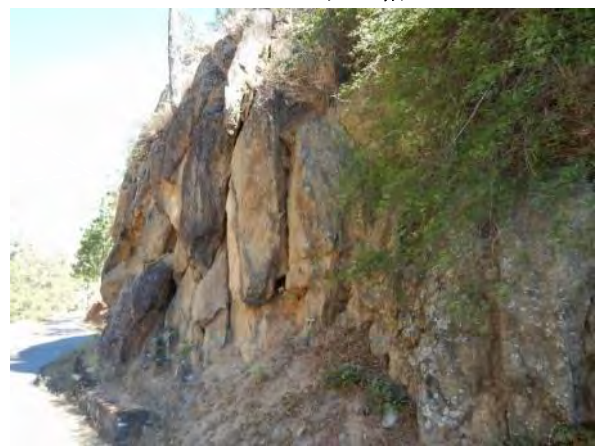
Photo 4 ダム地点左岸 (緩みのある片岩)
