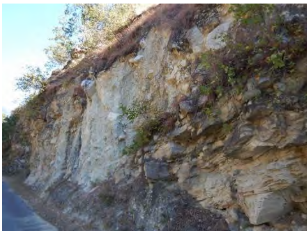
Photo 6 左岸の未固結堆積物
