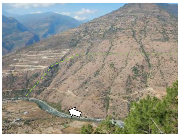
Photo 6 水圧管路および発電所地点
