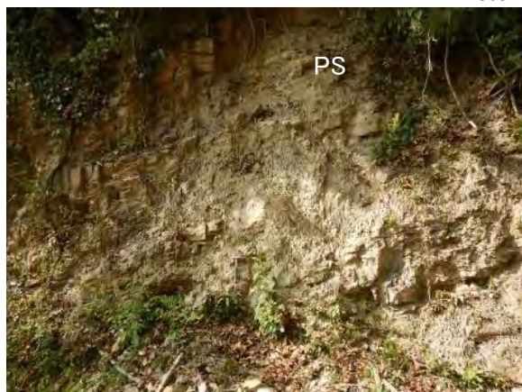
Photo 2 道路沿いの露頭 (風化片岩)
