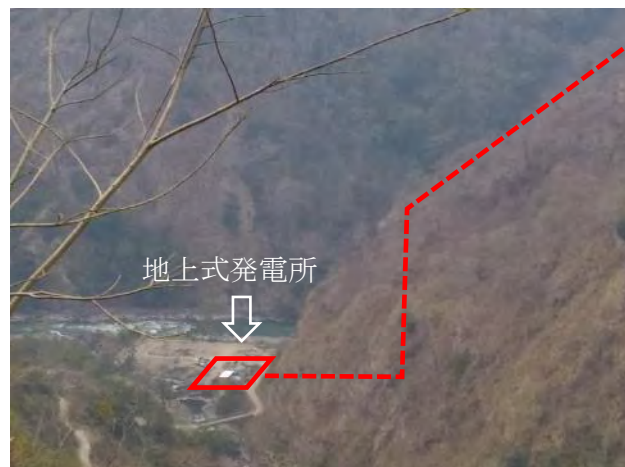
Photo 2 発電所及び水圧管路
