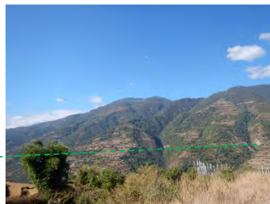
Photo 6 水路ルート (放水口側)
