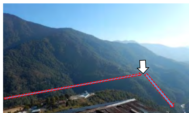
Photo 5 水路、サージタンク、水圧管路および発電所
