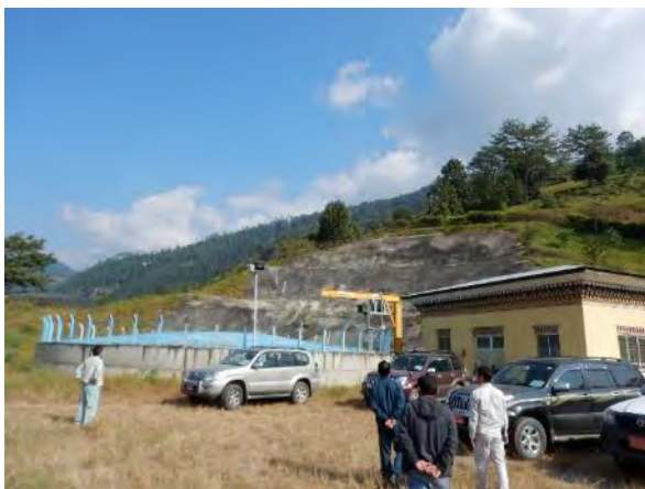
Photo 5 Dagachhu 発電所のサージタンク
