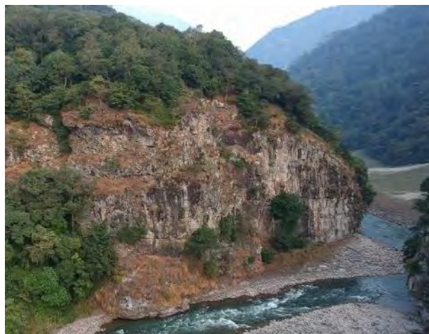
Photo 2 右岸アバットの露頭
