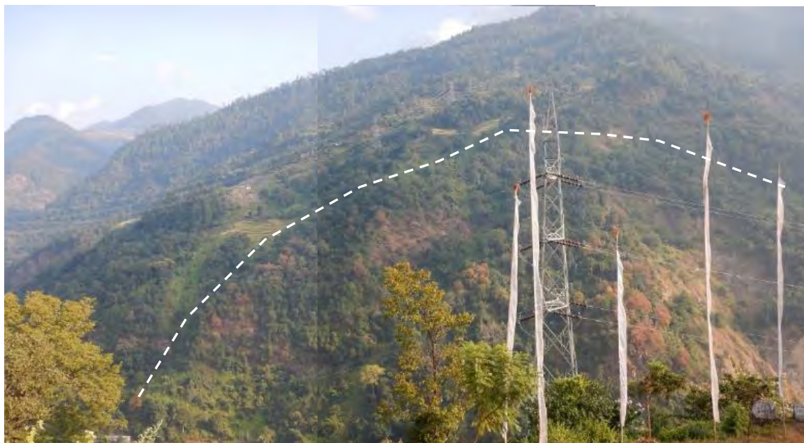
Photo 1 取水ダム左岸の岩盤クリーブ
