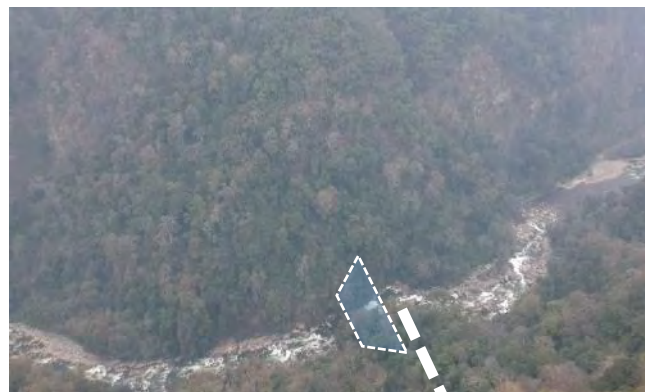
Photo 2 ダムサイトおよび取水口
