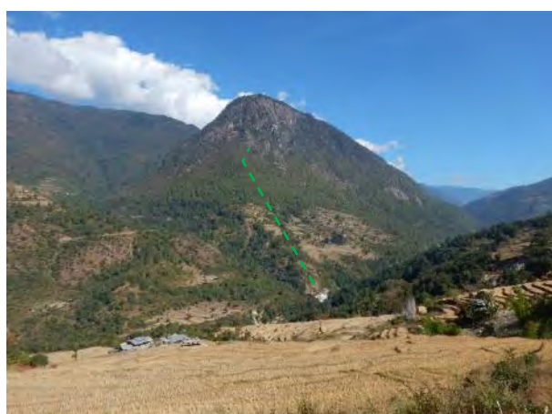
Photo 8 水圧管路および発電所
