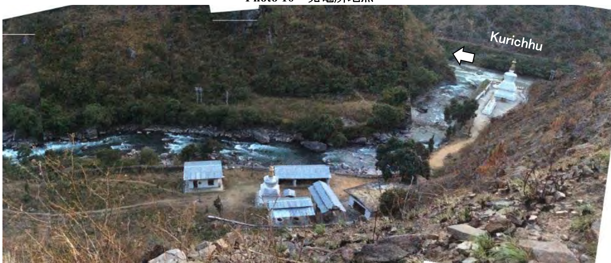
Photo 11 火葬場 (Kurichhu との合流点)
