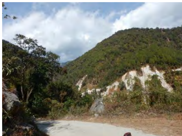
Photo 6 道路沿い露頭 (熱水変質による崩壊地)
