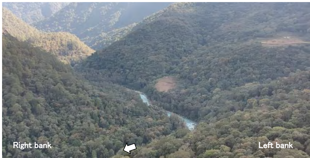
Photo 2 ダム地点 上流側
