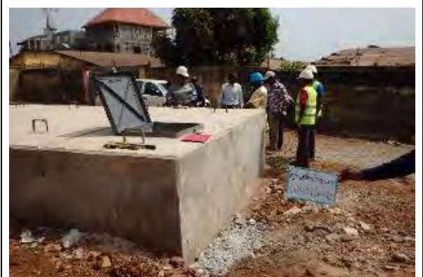
24. 自動緊急停止バルブ 仮引き渡し 撮影：2015年12月22日
