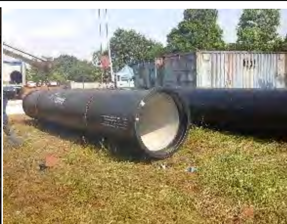
2. 修理用ダクタイル鋳鉄管の納入
