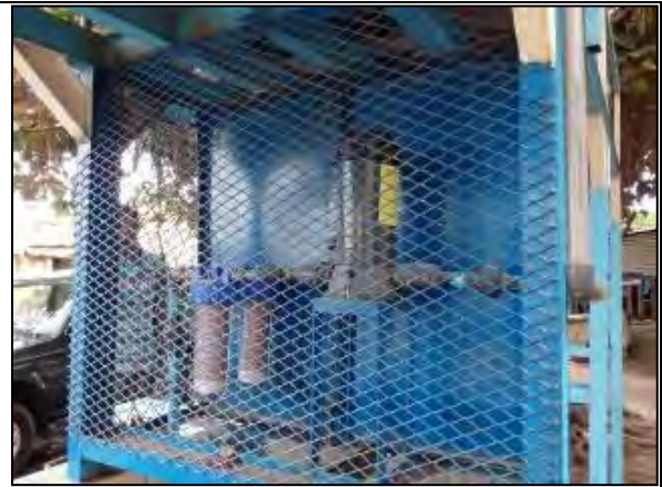
プレフィルターとフィルター（ここに水質によって異なるカートリッジを入れる、濁度除去、硝酸除去等）、塩素注入、フェンスから構成されるSEG標準の簡易水処理装置
