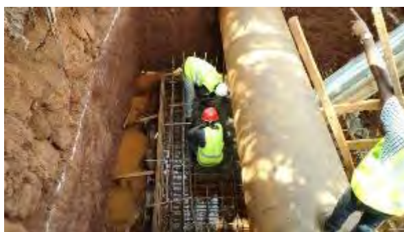
6. 圧力リーフバルブのコンクリート打設
