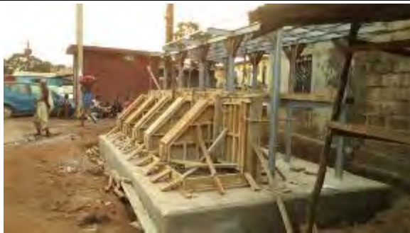
5. No.30 Devanture Famille Kaba 水栓躯体型枠工事 撮影：2016年4月19日
