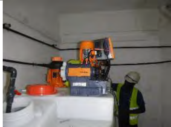
26. カキンボ薬品タンク、攪拌機及び薬品注入ポンプの設置 撮影：2018年8月8日
