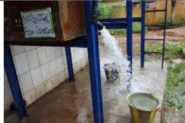
13. No10 Devanture Famille Elhadj Moussa Baldé 試運転 (水槽は満水なので水は途中の配管から 排出) 撮影：2016年9月24日
