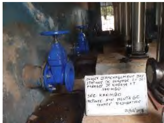
22. カキンボ送水ポンプ吸込側バルブ交換完了 撮影：2018年6月21日
