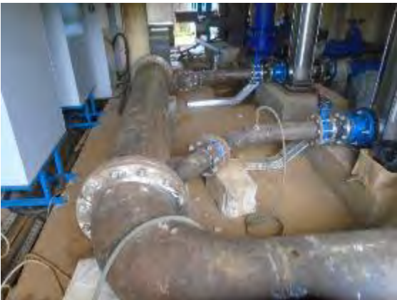
27. コバヤ 送水ポンプ廻りの配管工事 撮影：2018年8月19日
