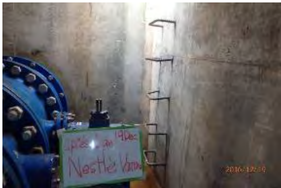
7. Nestlé 地区の流量調整弁室内状況、口径 700 mmの下流を望む。 撮影：2016年12月19日
