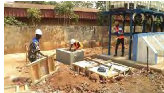
6. No6 Cloture Ecole Primaire De Solo primo 脱 型作業 撮影：2016年4月23日
