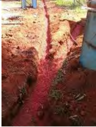
19. カキンボ F7,F7A 深井戸用配線工事 ケーブル埋設表示ネット設置 撮影：2018年5月10日
