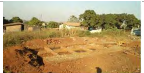
2. No.1 Carrefour Garage (Près famille Ibrahima Baldé) 基礎 土工事 撮影：2015年12月29日
