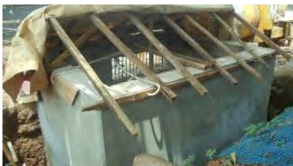
9. 圧力リリーフ弁室 コンクリート打設後の状況。 撮影：2015年6月24日
