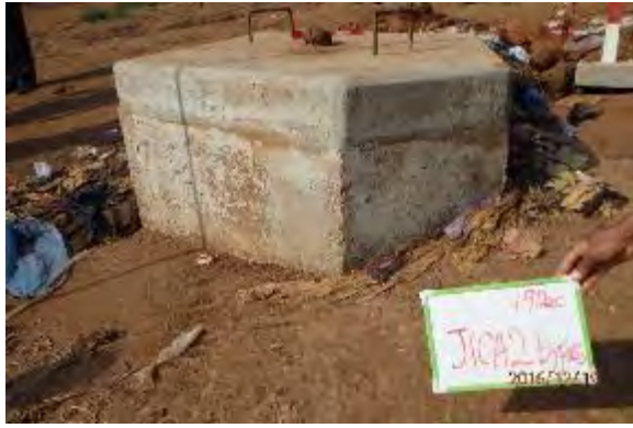
17. Sangoya 地区の JICA2 配水池取り出し口径 250 mm 制水弁柵状況。
