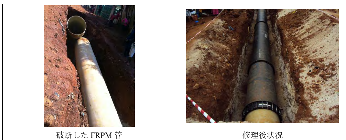
図 4-9 第 12 回破断（2014 年 11 月 12 日）
