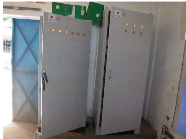
電源切替盤設置工事(コバヤ)
