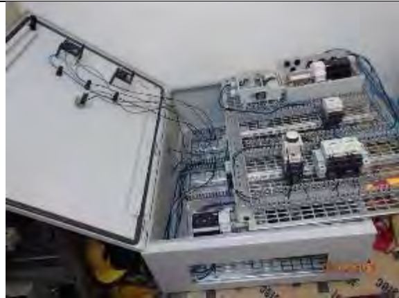
8. GTF 工場 制御盤内部の部品取付配線作業 撮影：2016年8月1日
