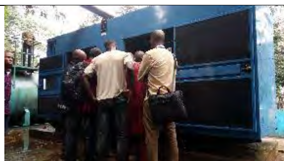
2. ディーゼル発電機 実機説明状況 撮影：2018年9月14日
