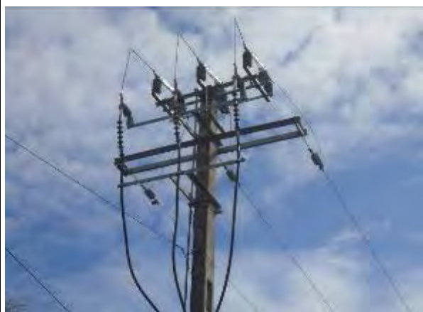
柱上高圧負荷開閉器完成写真
