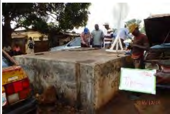
25. Sangoya 地区、口径 700 mm に F/M-4 流量計設置弁室状況、上流から下流を望む。
