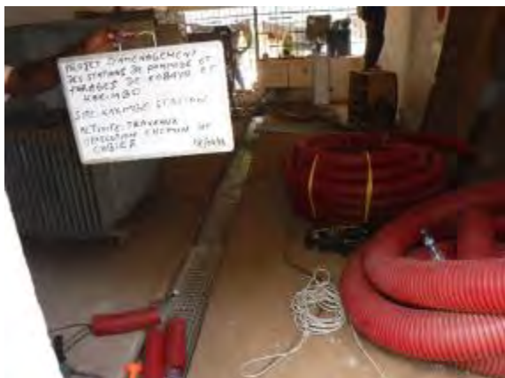
11. カキンボ送水ポンプ場電気室内配線工事 撮影：2018年4月10日
