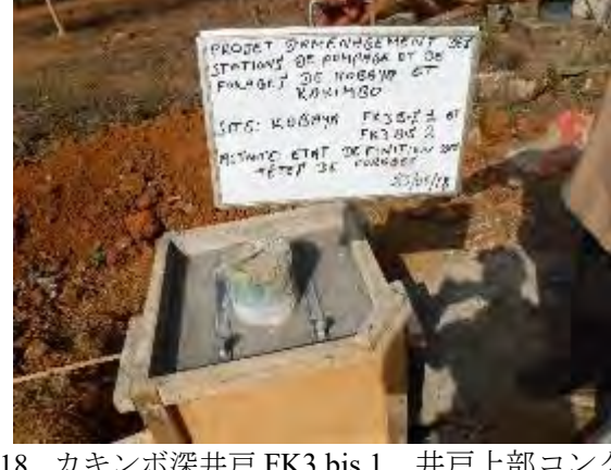
18. カキンボ深井戸 FK3 bis 1 井戸上部コンクリート打設後 撮影：2018年5月23日
