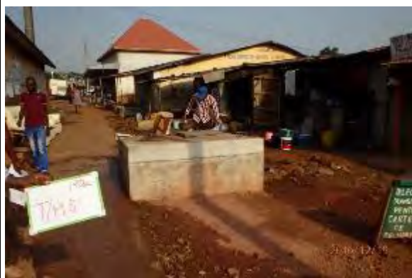
27. Sangoya 地区、Simbaya 配水池への送水管口径 600 mm に F/M-5 流量計設置のための新設弁室状況、下流から上流を望む。
