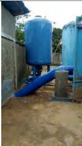
33. コバヤ エアーチャンバー設置完了 撮影：2018年9月21日
