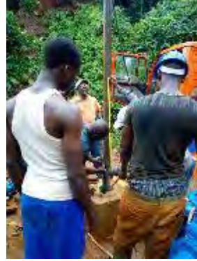
12. 水中モーターポンプ再設置 撮影：2017年9月13日
