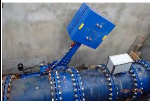
21. 自動緊急停止バルブ 弁及び管の設置完了 撮影：2015年12月8日
