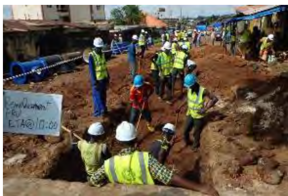
10. 自動緊急停止バルブ FRPM 管からダクタイル鉄管への交換工事 掘削 撮影：2015年9月9日
