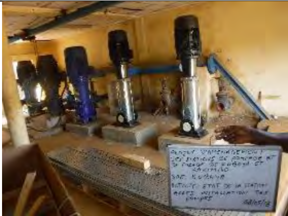
15. コバヤ送水ポンプ設置完了 撮影：2018年5月4日
