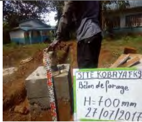
6. 井戸ケーシング構造出来形測定 撮影：2017年7月27日
