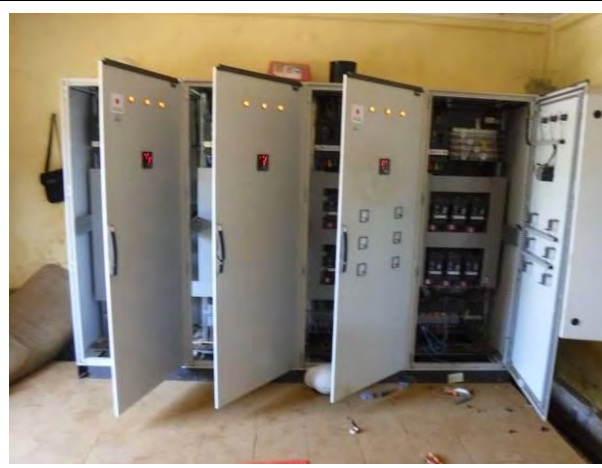
低圧盤の調達・設置・配線(コバヤ)
