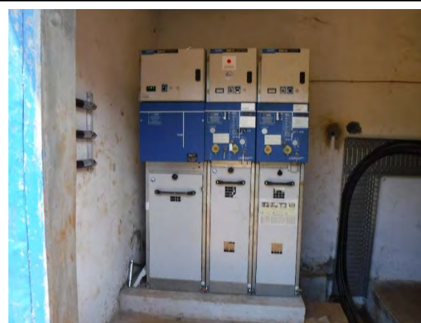
高圧盤の調達・設置・配線(カキンボ)
