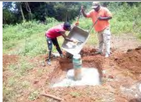
2. 井戸ケーシング構造均しコンクリート打設 撮影：2017年7月12日
