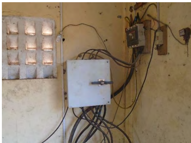
電源切替盤設置工事(コバヤ)
