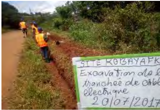
5. 電気ケーブル敷設用掘削作業 撮影：2017年7月20日
