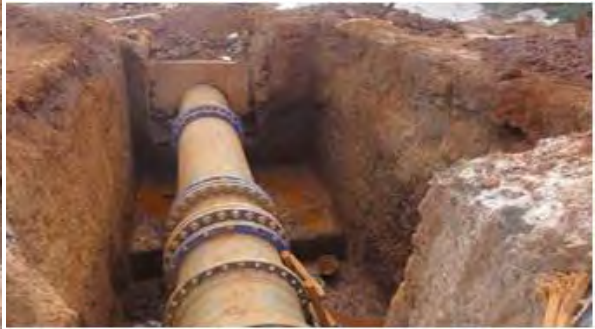
14. Sangoya 地区の減圧弁室 掘削完了 撮影：2015年10月29日
