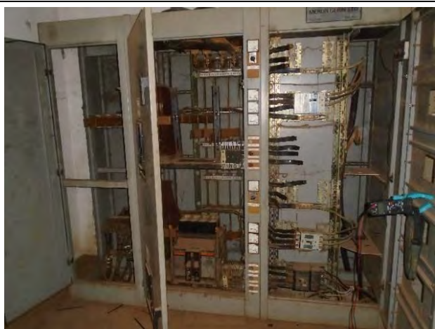
低圧盤の調達・設置・配線(カキンボ)
