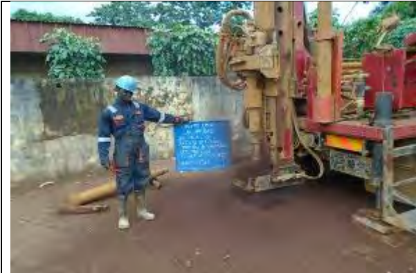
1. No6 Clôture Ecole Primaire De Solo primo 掘削開始 撮影：2015年8月14日
