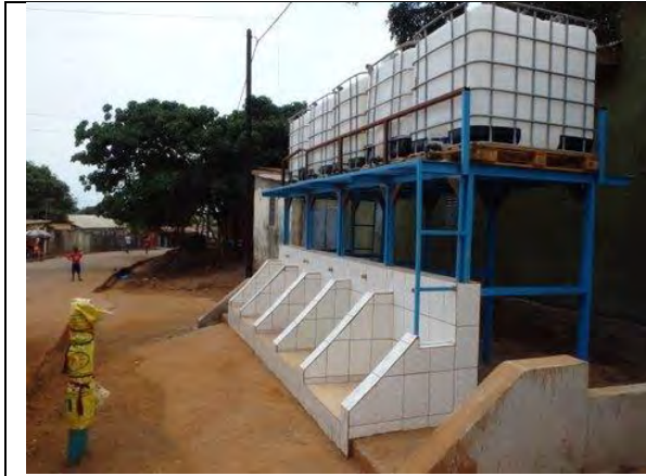
上部にポリエチレンタンク、地上には5個の水栓があるSEG標準タイプの公共水栓
