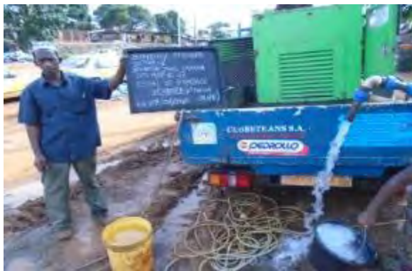
9. No7 Devanture Parc Camion 揚水試験 撮影：2015年8月7日
