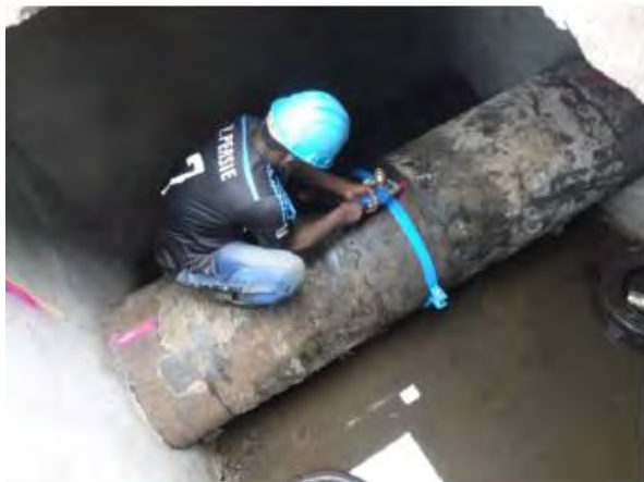
15. Sangoya 地区 F/M-4 鋼管口径 700mm 流量計 止水栓取付状況。 撮影：2015年10月6日
