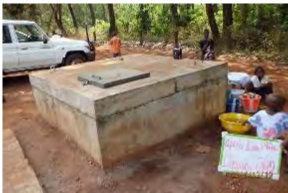
21. Dabompa 地区のバイパス弁室上流、口径 1100 mm 流量計弁室状況、下流から上流を望む。
