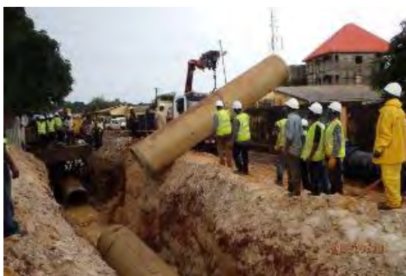
11. 自動緊急停止バルブ FRPM 管からダクタイル鉄管への交換工事 FRPM 管引上げ 撮影：2015年9月9日
