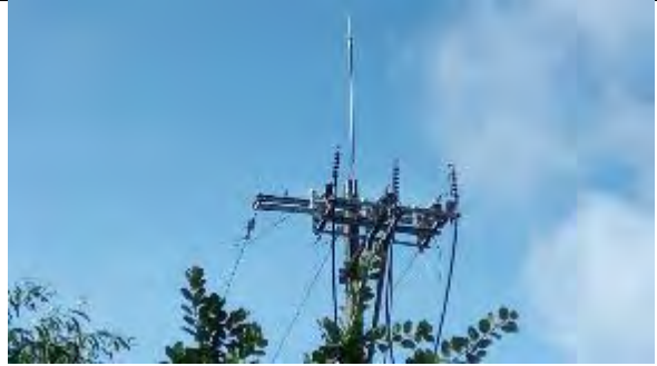
32. コバヤ 電柱への負荷断路器及び避雷針の設置 撮影：2018年9月19日
