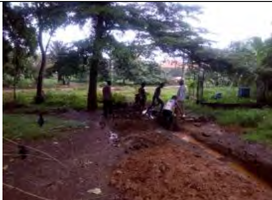
1. 導水管埋設管路の掘削工事 撮影：2017年7月10日
