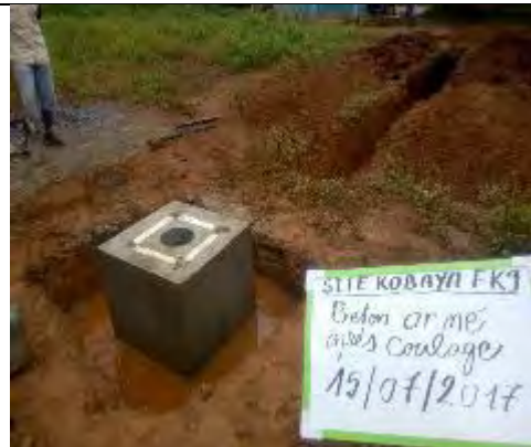
4. 井戸ケーシング構造コンクリート打設 撮影：2017年7月15日
