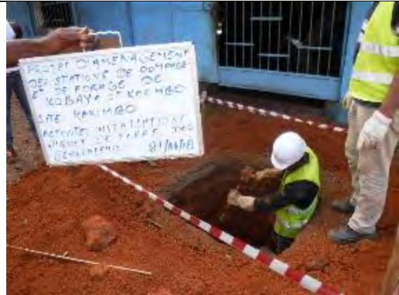
14. カキンボ ディーゼル発電機用接地極設置 撮影：2018年4月21日
