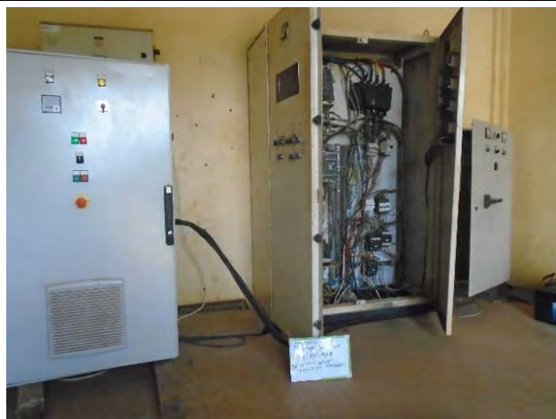
低圧盤の調達・設置・配線(コバヤ)
