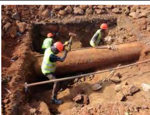
7. NESTLÉ 地区の口径 700mm 鋼管部流量計 (F/M-1) 柵 掘削工 (軟岩~硬岩) 撮影：2015年5月2日
