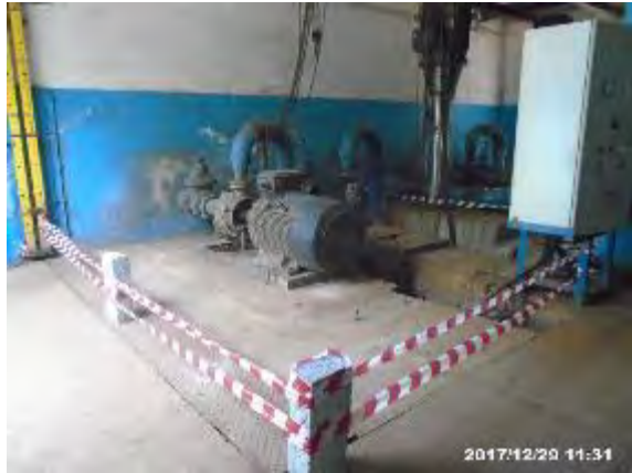
1. カキンゴ送水ポンプ設置工事 基礎工事準備 撮影：2017年12月29日
