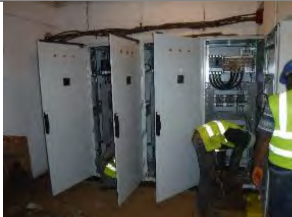
13. カキンボ送水ポンプ場配電盤設置工事 撮影：2018年4月10日
