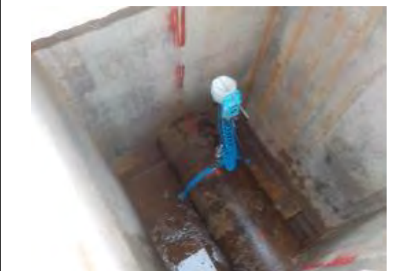
28. Sangoya 地区、Simbaya 配水池への送水管口径 600 mm に F/M-5 流量計設置状況。 (稼働中)
