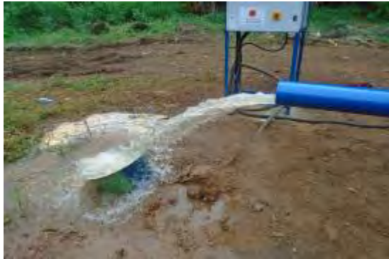
11. 試運転状況 撮影：2017年8月31日
