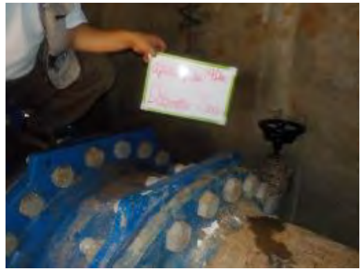
12. Dabompa 地区のバイパス弁室内部状況、口径 700 mmライン状況。
