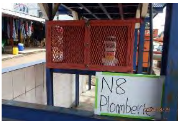
11. No8 Face Parc camion 塩素注入器設置 撮影：2016年8月29日
