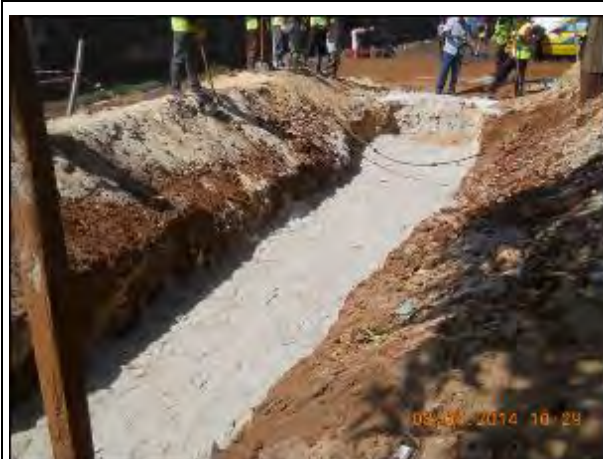
1. 既存 FRPM 管埋設位置の確認
