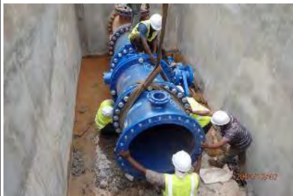
21. 自動緊急停止バルブ 弁及び管の設置 撮影：2015年12月7日
