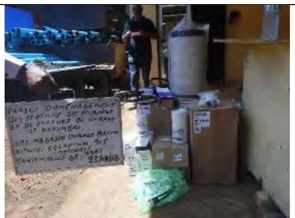
2. ディーゼル発電機消耗品 資材納入検査状況 撮影：2018年9月14日
