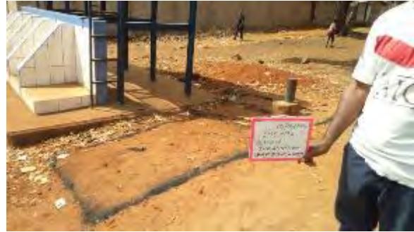
2. No.2 Près de chez Fofana Syndicat 発電機基礎 の位置出し 撮影：2016年4月2日
