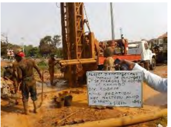
5. コバヤ観測井建設工事 掘さく工事中 撮影：2018年2月8日
