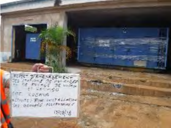
25. ディーゼル発電機設置完了 撮影：2018年8月19日
