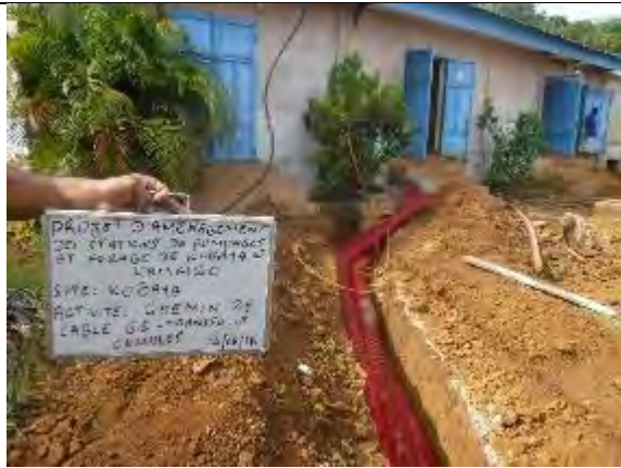
21. コバヤ配線工事 動力電源切替場と配電盤間のケーブル布設 撮影：2018年6月4日
