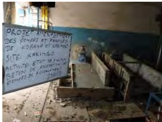
4. カキンゴ送水ポンプ設置工事 基礎工事完成 撮影：2018年1月29日
