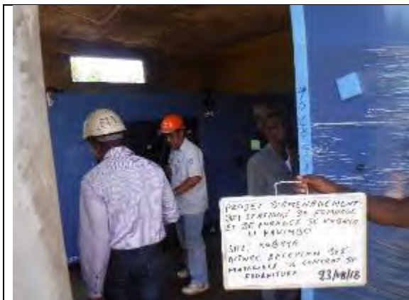
3. ディーゼル発電機本体 資材納入検査状況 撮影：2018年8月23日
