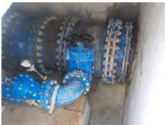
15. ENTA 地区の減圧弁内部状況、口径 900 mm x 口径 250 mm下流の減圧弁状況。
