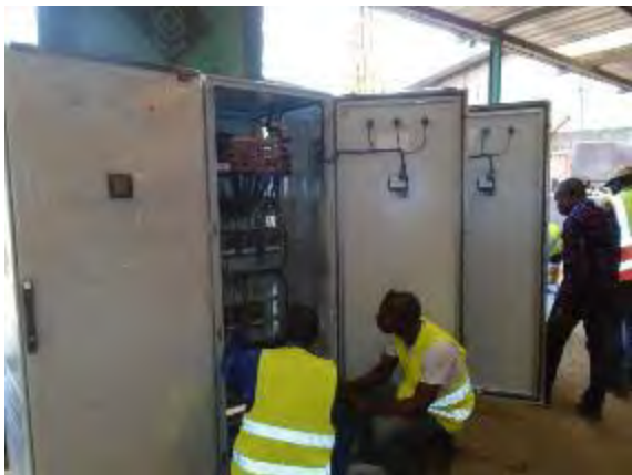
10. コバヤ、カキンボ 送水ポンプ制御盤組立 撮影：2018年3月30日
