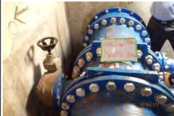
8. Nestlé 地区の流量調整弁室内状況、口径 700 mmの下流を望む。 撮影：2016年12月19日
