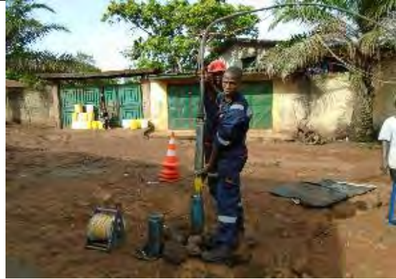
8. No13 Chez Mr Diop 揚水試験用水中モーターポンプ設置 撮影：2015年6月23日
