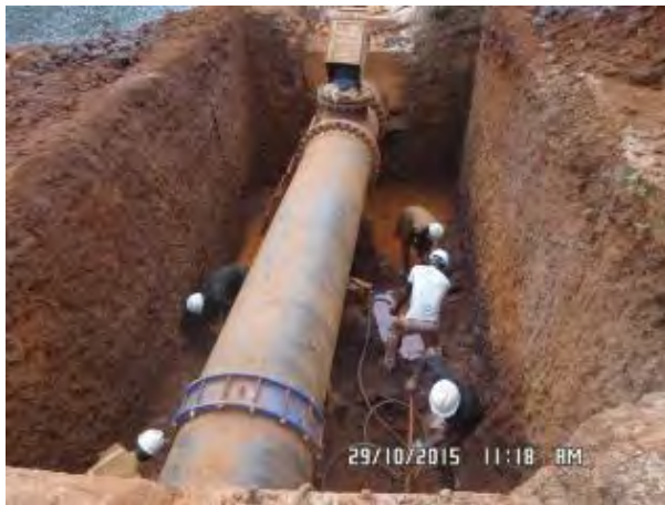
13. 自動緊急停止バルブ 弁室部の掘削進捗状況 撮影：2015年10月29日
