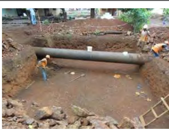
8. Dabompa 地区の鋼管口径 700mm~ ダクタイル管口径 1,100mm バイパス弁室 掘削工 撮影：2015年5月30日
