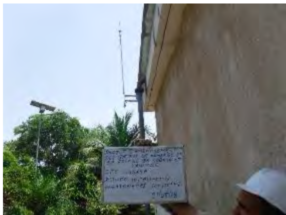
17. 避雷針設置完了 撮影：2018年5月21日
