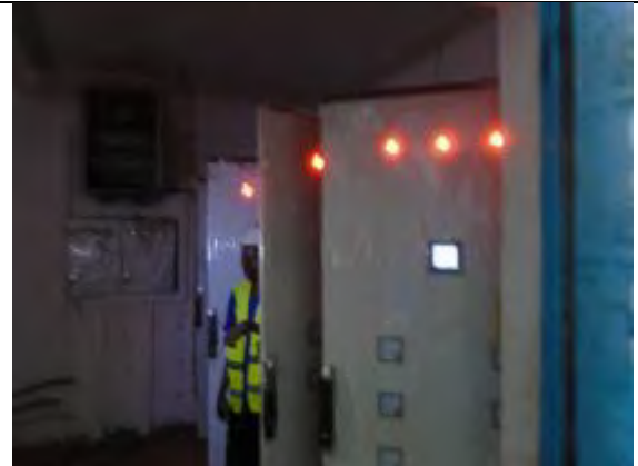
30. コバヤ 低圧配電盤の試運転 撮影：2018年8月29日
