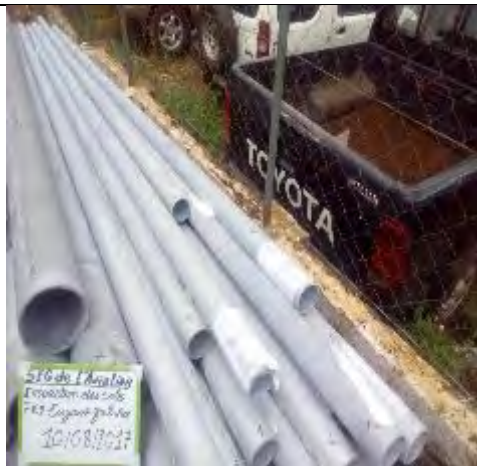
9. クラウンエイジェンツ調達揚水管検収 撮影：2017年8月10日
