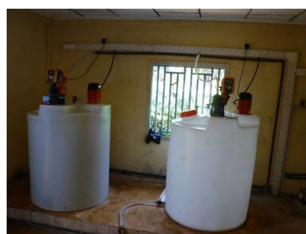
薬品注入装置調達・搬入・据付(コバヤ)
