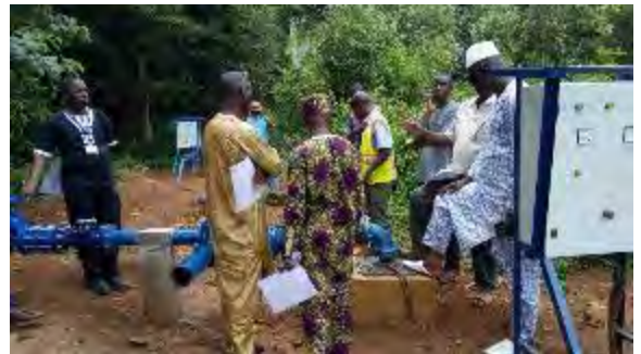
34. コバヤ 水中モーターポンプ FK-3-bis1 設置および配管工事 SEG 立会完工検査 撮影：2018年8月29日
