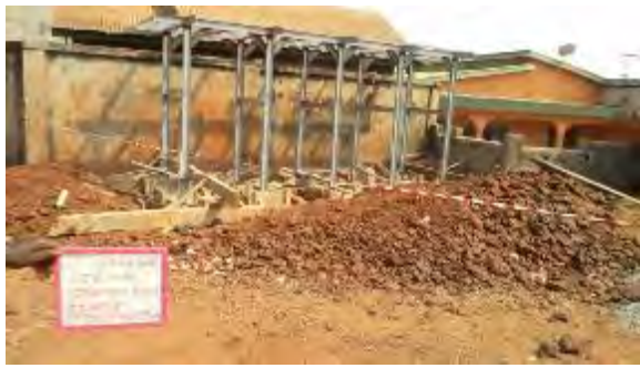
3. No.35 Près de la Mosquée Yattara 鉄骨構造設置工事 撮影：2016年4月27日
