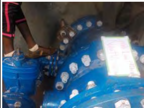
6. Nestlé 地区のバイパス弁室内状況、口径 700 mmの上流を望む。 撮影：2016年12月19日
