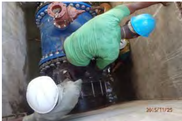
18. 圧力リリース弁室 管の接続完了 撮影：2015年11月25日
