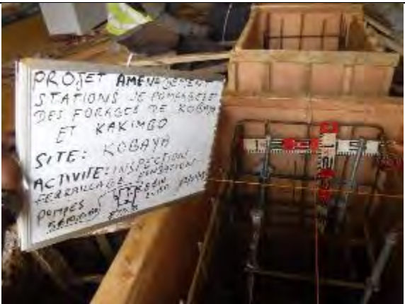
3. コバヤ送水ポンプ設置工事 基礎鉄筋コンクリート配筋完了 撮影：2018年1月22日
