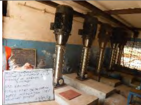
16. カキンボ送水ポンプ設置完了 撮影：2018年5月9日
