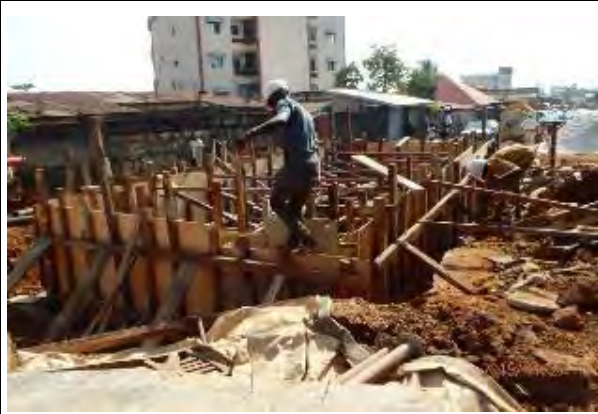
19. 自動緊急停止バルブ 弁室の型枠設置 撮影：2015年11月27日
