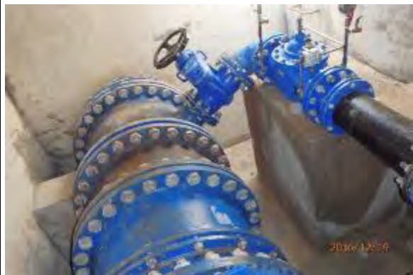
14. ENTA 地区の減圧弁内部状況、上流から下流を望む、口径 900 mm x 口径 250 mm減圧弁状況。
