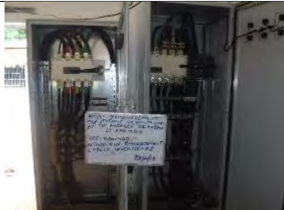
24. カキンボ動力電源切替盤のケーブル接続完了 撮影：2018年7月28日
