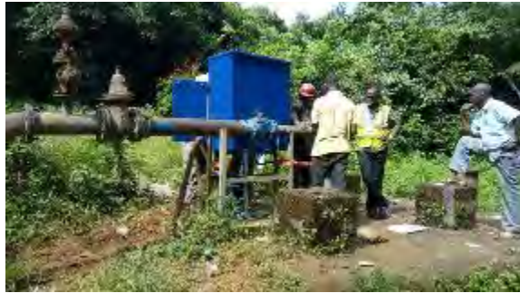
31. カキンボ 深井戸 F8 への水中モーターポンプ設置 水中モーターポンプ試運転 撮影：2018年9月15日
