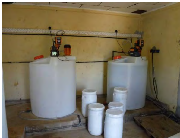
薬品注入装置調達・搬入・据付(カキンボ)
