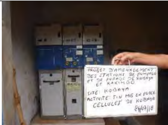
23. コバヤ高圧受配電盤の設置完了 撮影：2018年7月26日
