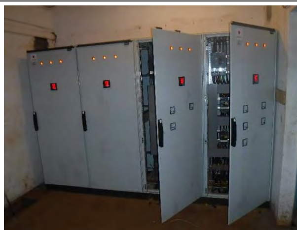
低圧盤の調達・設置・配線(カキンボ)
