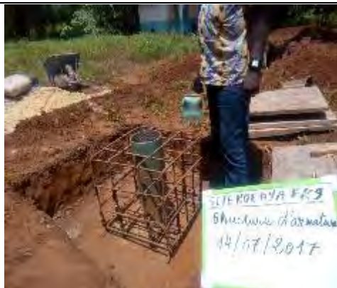
3. 井戸ケーシング構造配筋作業 撮影：2017年7月14日
