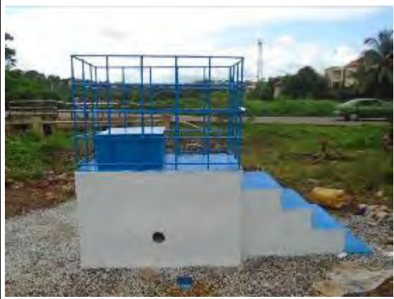
観測井工事完成写真
