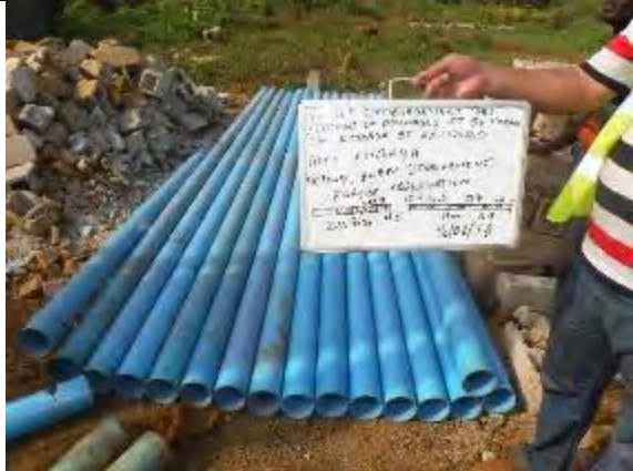
7. コバヤ観測井建設工事 ケーシング・スクリーンの検査 撮影：2018年2月16日
