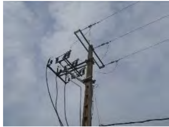
柱上高圧負荷開閉器完成写真
