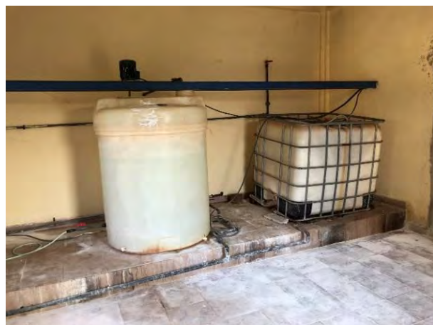
薬品注入装置調達・搬入・据付(カキンボ)
