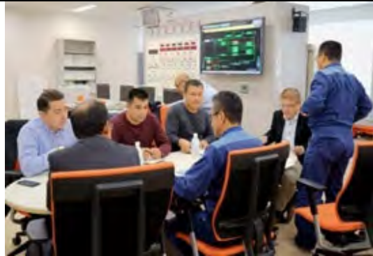
【Сбой питания на электростанции: выключен свет】
