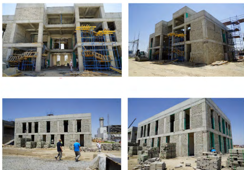
Фотография 2.3.5-1 Строящееся здание НУЦ (главное здание на стороне ПГУ-2: сфотографировано в октябре 2018 г.)
