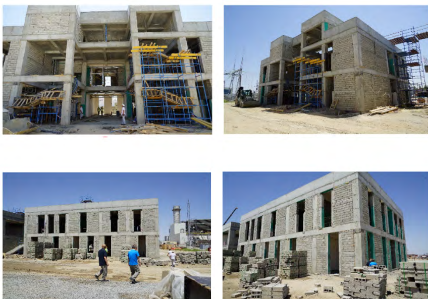
写真 2.3.5-1 建設中の NTC 建屋(CCPP-2 側の主棟：2018 年 10 月撮影)
