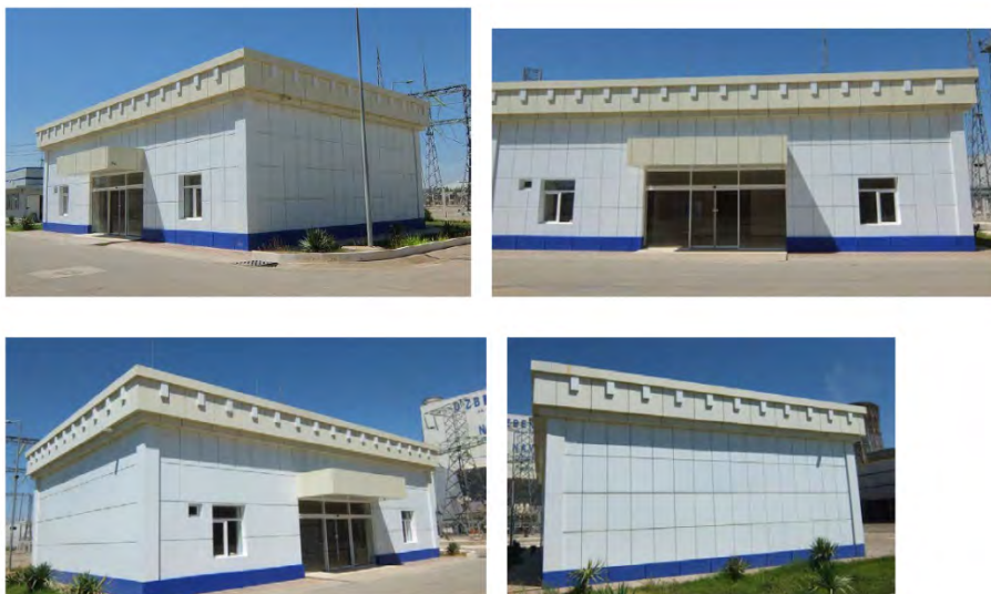
写真 2.3.5-2 電気分野の CCPP-1 側建屋(2018 年 10 月撮影)
