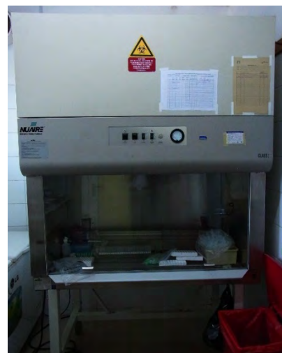
NHA 既存検査室内のバイオセーフティキャビネット
