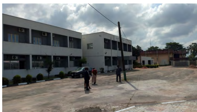
写真5 CPHL 既存棟、専用ゲート、ガードハウス。奥には連邦保健省の図書館、右手は前面道路。新施設建設用地は左手奥に位置する。
