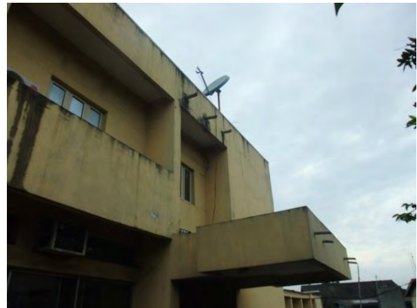
既存施設屋根雨樋。自然流下のうえ場内で浸透処理または外部道路へ放流している。
