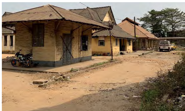
写真1 新施設建設用地。既存建物、樹木、電柱の撤去移設を要する。地中障害物は発見されていない。
