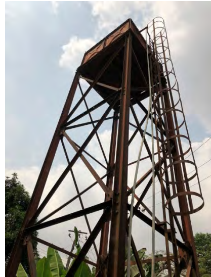
既存高架水槽。樹脂製のタンクで容量は8トン。
