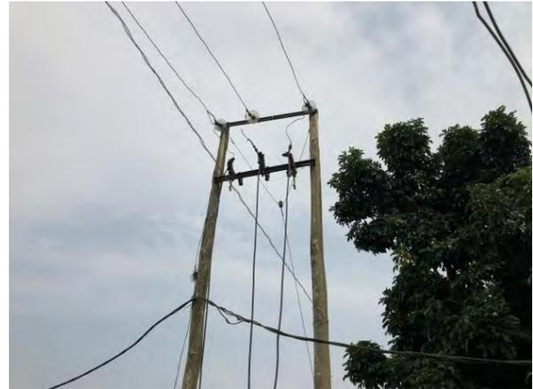
11kV 中圧配電網の引き込み電柱
