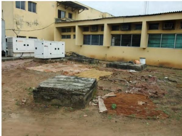
地中埋設型の浄化槽。腐敗槽、沈殿槽の2槽式で処理水は場内で地中浸透としている。写真奥は非常用ディーゼル発電機。
