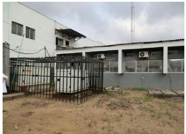
写真6 CPHL 非常用発電機および浄化槽群。NRL 同様に2層式で場内浸透処理を行っている。
