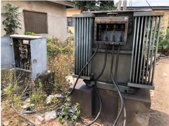
屋外型の既存変圧器300KVA。引込み電圧11kVから415Vへ降圧している。
