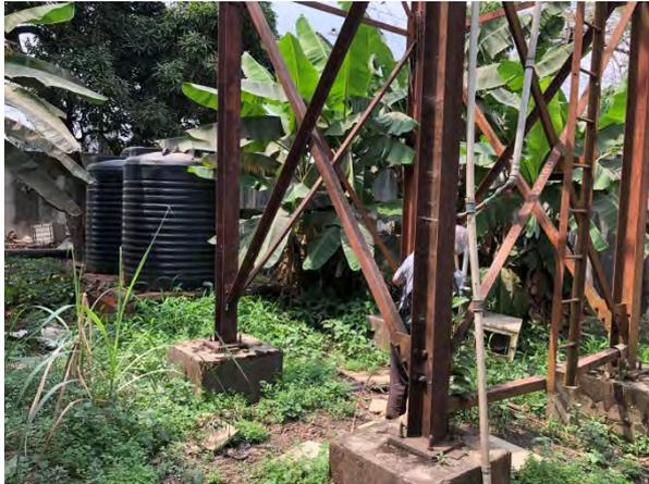
既存施設へは、井戸水をポンプアップして上水の引き込みを行っている。写真奥、地上置き型の樹脂製受水槽。容量は5トン×2基。
