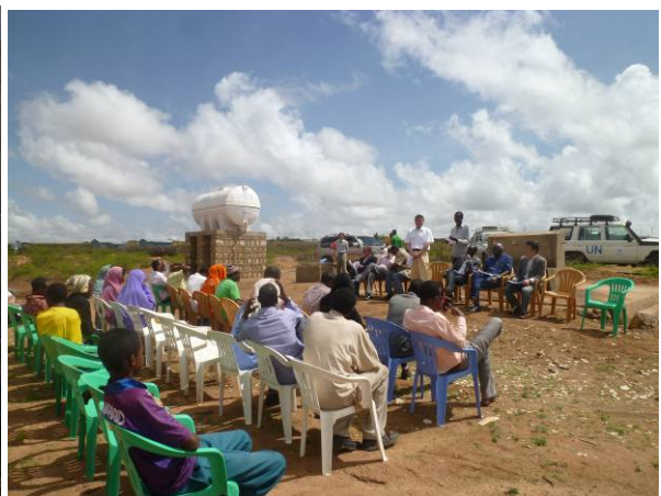
Kabribeyah 市給水施設工事の完工式の実施 ジャラル溪谷給水システムの改善のための給水施設工事が実施され、Kabribeyah 市に 5 箇所の公共水栓と貯水槽が設置された。
