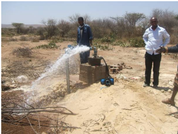
パイロットプロジェクトで設置した井戸利用 パイロットプロジェクトで掘削した井戸を利用する前に Kabri bayah 市までの配管の通水試験が実施された。
