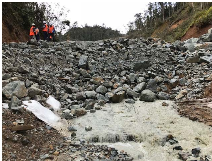
写真 4.6 導水暗渠の下流末端部
