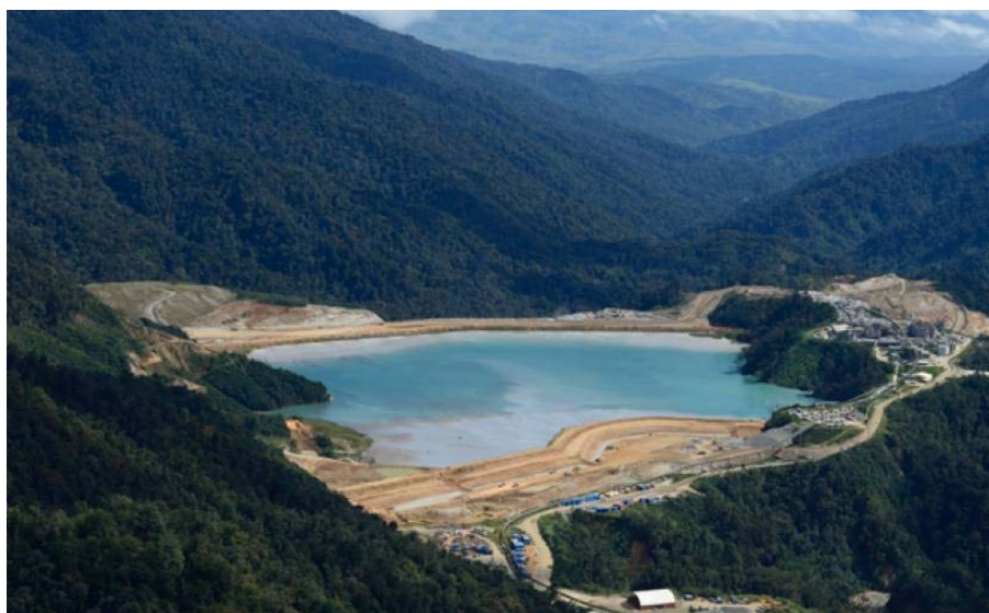
写真 4.5 尾鉱ダム（手前の堤体が Saddle dam、奥の堤体が Main dam）
