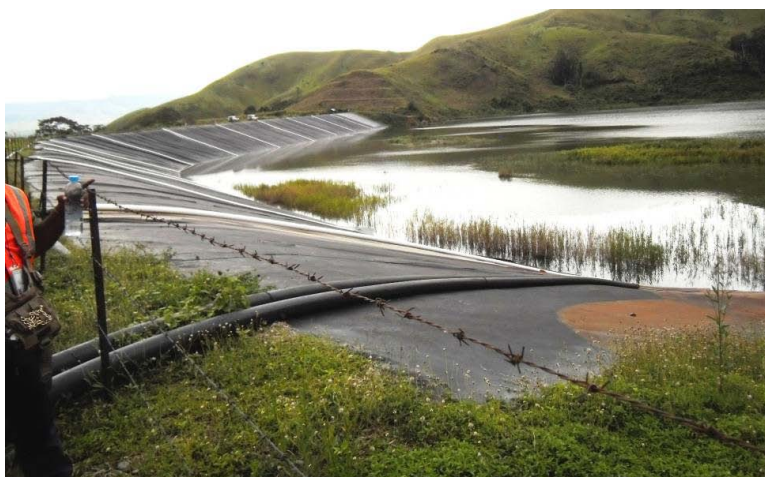
写真 4.4 現在の尾鉱ダムの状況
