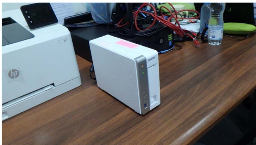
写真 5.1 NAS 設置状況
