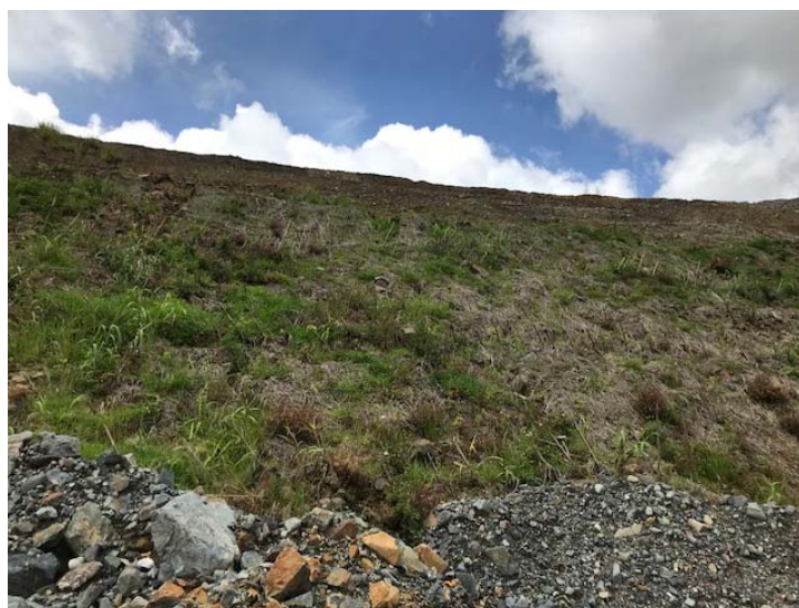
写真 4.7 成形した法面の緑化施工部
