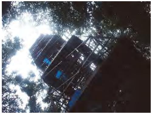
プロジェクトで修復したZF2 タワー
