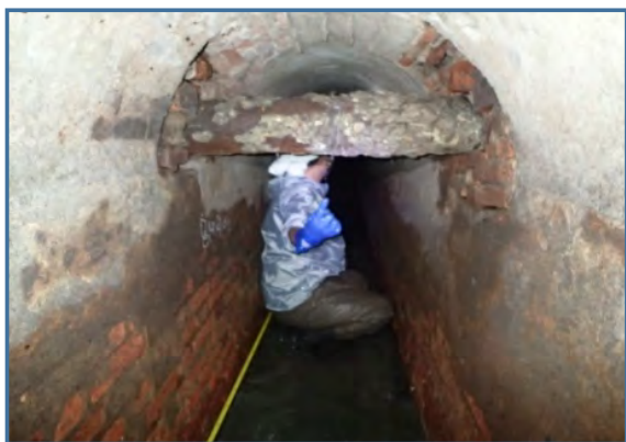
⑨No.5 Cach Mang Thang 8 における 埋設管の状況
