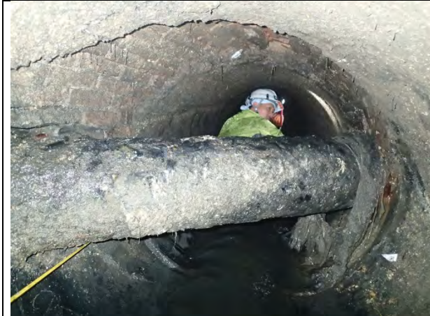
写真 2-3 : No. 7 Cong Quynh 通りの横断管 (潜行目視調査)
