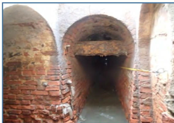
⑩No.5 Cach Mang Thang 8 における 埋設管の状況
