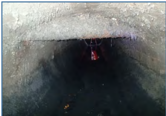
⑤No.3 Yersin における埋設管の状況
