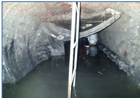
⑥No.3 Yersin における埋設管の状況
