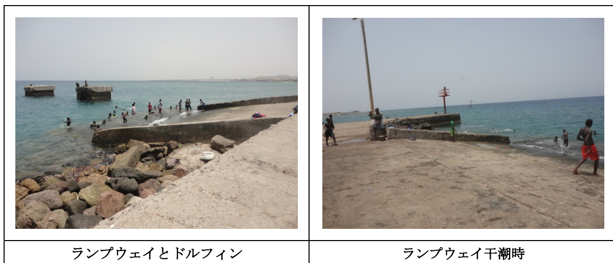
写真：タジュラ港既存フェリー接岸施設の状況
