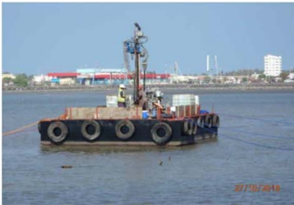
土質調査実施状況:ジブチ港
