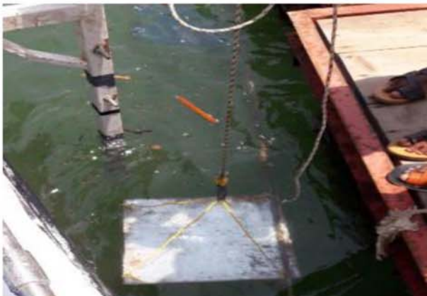
深浅測量(キャリブレーション)実施状況:ジブチ港
