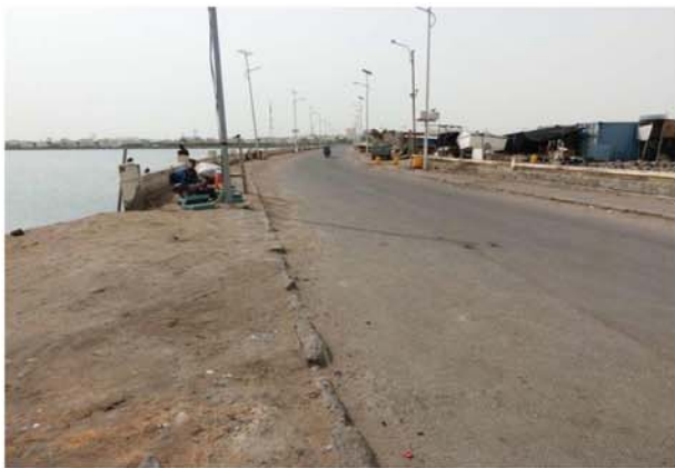
ジブチ港新規フェリーターミナル計画地 出入口からジブチ市方面を望む(2 nd July 2018)
