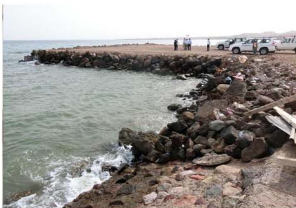
タジュラ港視察・ヒヤリング タジュラ港新規フェリーターミナル計画地視察ヒヤリング時、フランス援助水産施設向け埋立地を東側から西側へ望む(3 rd July 2018)
