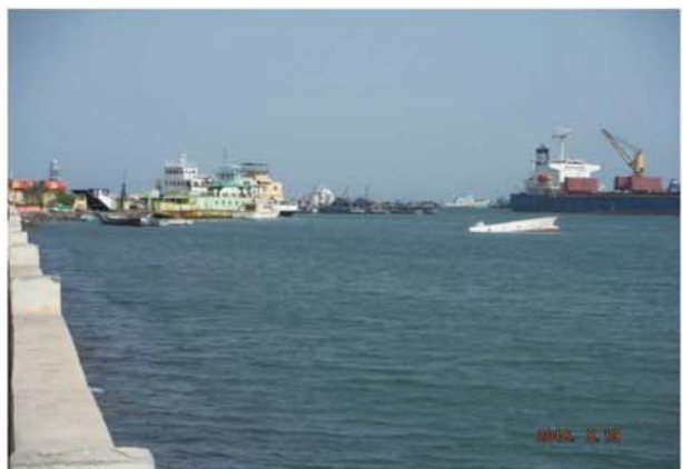
ジブチ港内沈船 ジブチ港内沈船(19 th JAugust 2018)
