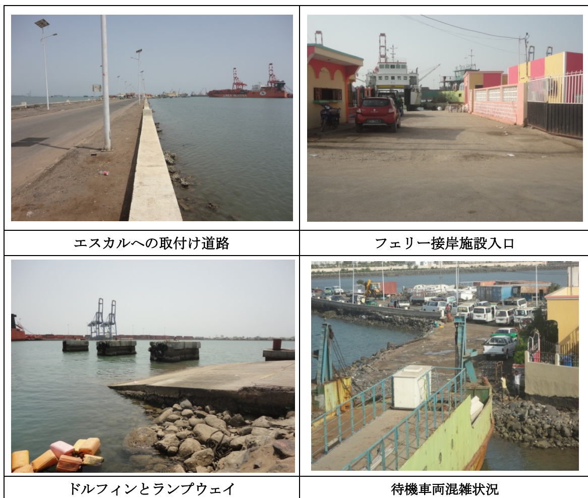
写真：ジブチ港既存フェリー接岸施設の状況
