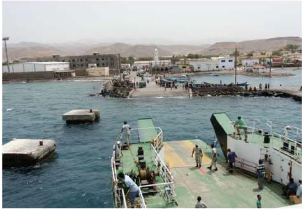
タジュラ港フェリー着岸直前 タジュラ港フェリーターミナルの到着待ち(接岸直前)の状況、ランプを降ろして進入(3 rd July 2018)
