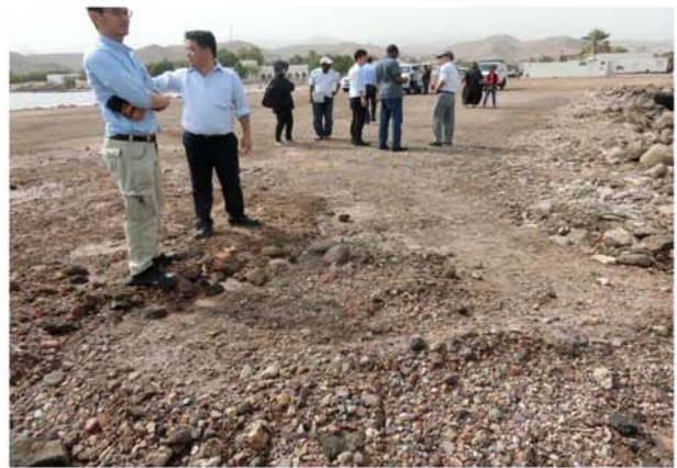
タジュラ港視察・ヒヤリング タジュラ港新規フェリーターミナル計画地視察ヒヤリング時、IFAD援助水産施設向け埋立地を南側から北側へ望む(3 rd July 2018)
