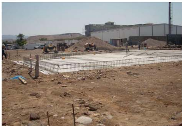
タジュラ港関連プロジェクト進捗状況 建築基礎工事((28 th May 2019)
