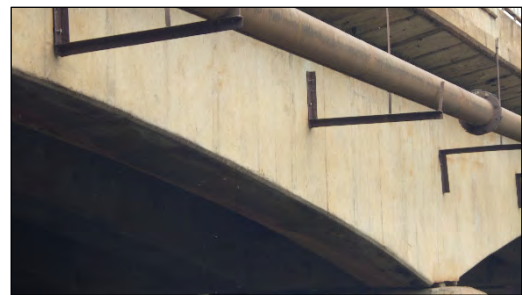
写真 3-2-4 橋梁添架下水道管現況
