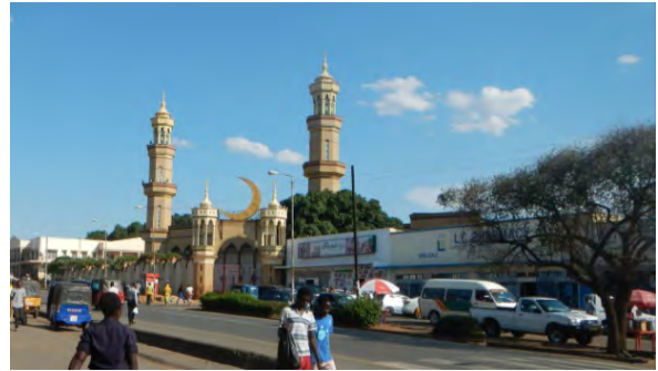
マランガランガ JCT 付近に位置する宗教施設 移転が困難なため、線形計画及び拡幅計画時に 考慮が必要である。
