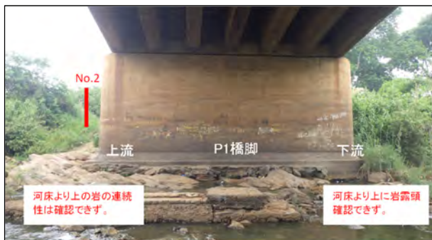
写真 3-2-1 橋脚付近の現況
