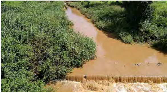
雨季のリロングエ川の流況 (橋梁の上流側、降雨直後) 調査時には降雨量が少なく、乾季と比較し増水は顕著ではなかった。
