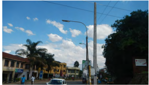
地上ユーティリティ 道路拡幅により撤去或いは移設が必要になる。
