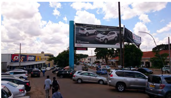
副道の状況 (サンバードリロングウェホテル JCT~ケニヤッタ JCT) 副道は道路・店舗側は駐車帯、その間は車両及び 歩行者の通行・歩行帯として利用されている。
