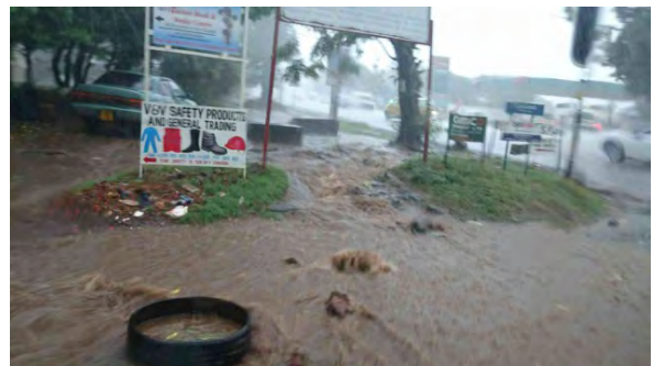
サンバードリロングウェホテル JCT 付近 降雨時の道路排水状況。
