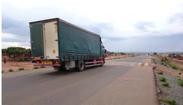
西バイパスと利用大型車両 横断歩道部にハンプが設けられている。
