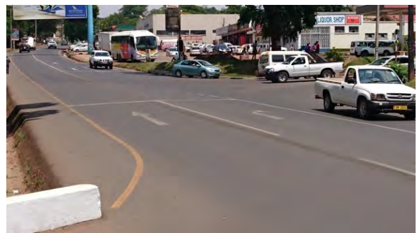
サンバードリロングウェホテル JCT 付近 奥側の直進車線と手前側の右折車線が 正対しており、正面衝突の危険性が高い。
