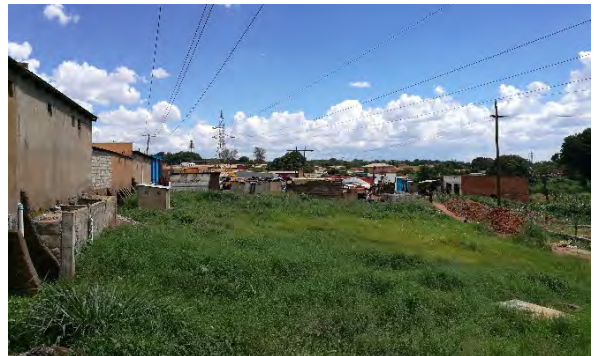
追加調査区間用地 6 (河川近傍の不法建物、鉄塔、電柱・電線) 建物、電線の移設が必要になる可能性がある。
