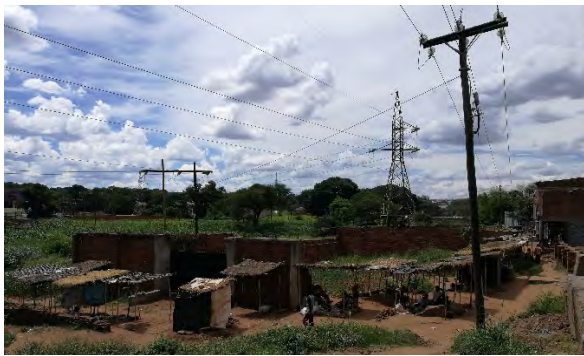
追加調査区間用地 5 (河川近傍の不法建物、鉄塔、電柱・電線) 建物、電線の移設が必要になる可能性がある。
