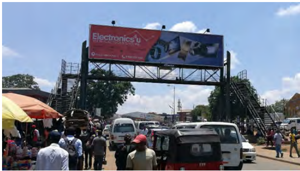
広告付き横断歩道橋 道路拡幅により撤去或いは移設が必要になる。
