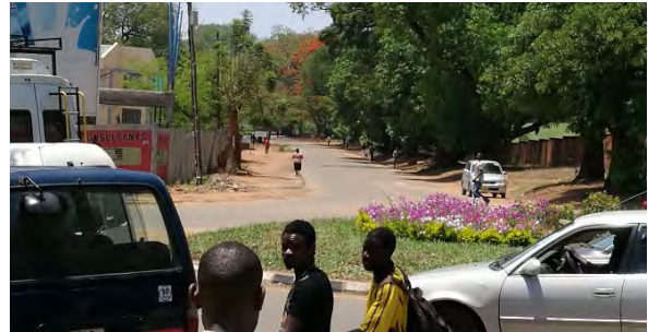
追加調査区間既存道路 2 (タウンホール RA) 手前がタウンホール RA、右がゴルフ場。2 車線が確保されている。
