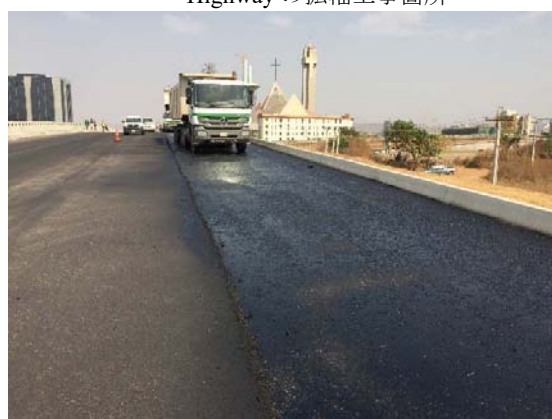
CBD 内幹線道路のフライオーバー新設
