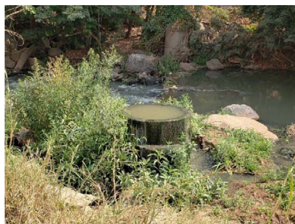
No2 : 既存マンホールから汚水の越流
