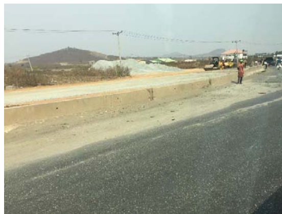
Highway の拡幅工事箇所
