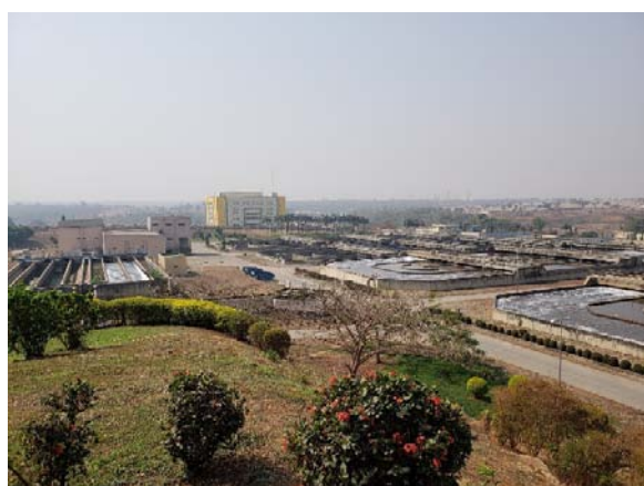
No.1 : Wupa 下水処理場全景
