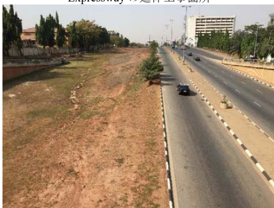
CBD 内幹線道路の片側暫定供用
