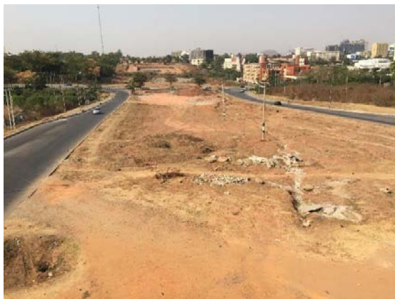
Expressway の延伸工事箇所
