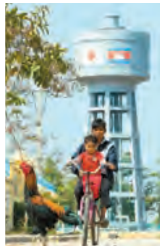
Cambodge : Un château d'eau géré par le service des eaux de Siem Reap dans le cadre du projet de renforcement des capacités pour le système d'approvisionnement en eau. [Photo : Kenshiro Imamura]
