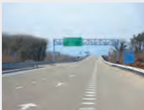
La section est déjà en service. La JICA intensifiera son aide pour terminer l'ensemble de la route est-ouest.
