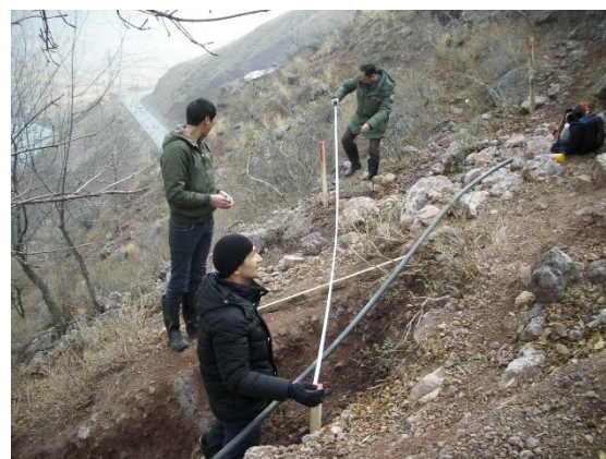
写真 2-4 地すべり計測杭の設置
