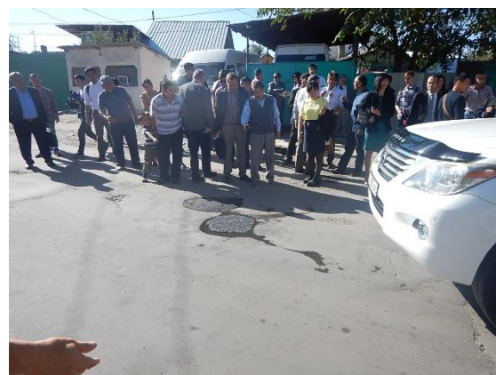
写真 2-26 道路補修材料(エクセルパッチ)のデモンストレーション
