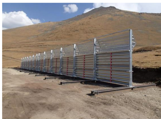
写真 2-10 地吹雪パイロットプロジェクト(防雪柵の建設)
