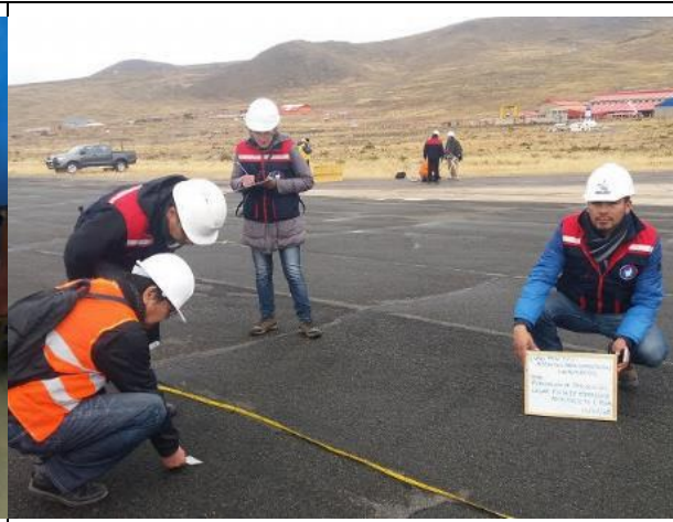
実践研修:アスファルト技術と空港における実践
