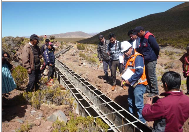
トマベ市 APC 事業進捗状況視察 (2018/9/4)
